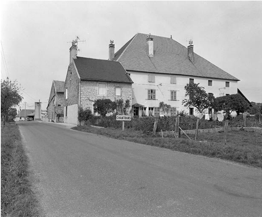
Vue d'ensemble depuis la RN 492. 25, Chantrains
