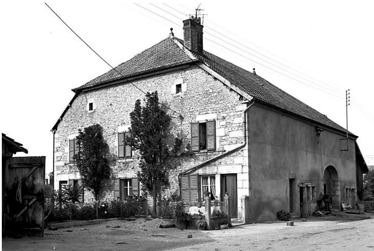
Façade antérieure et face latérale droite. 25, Chantrains
