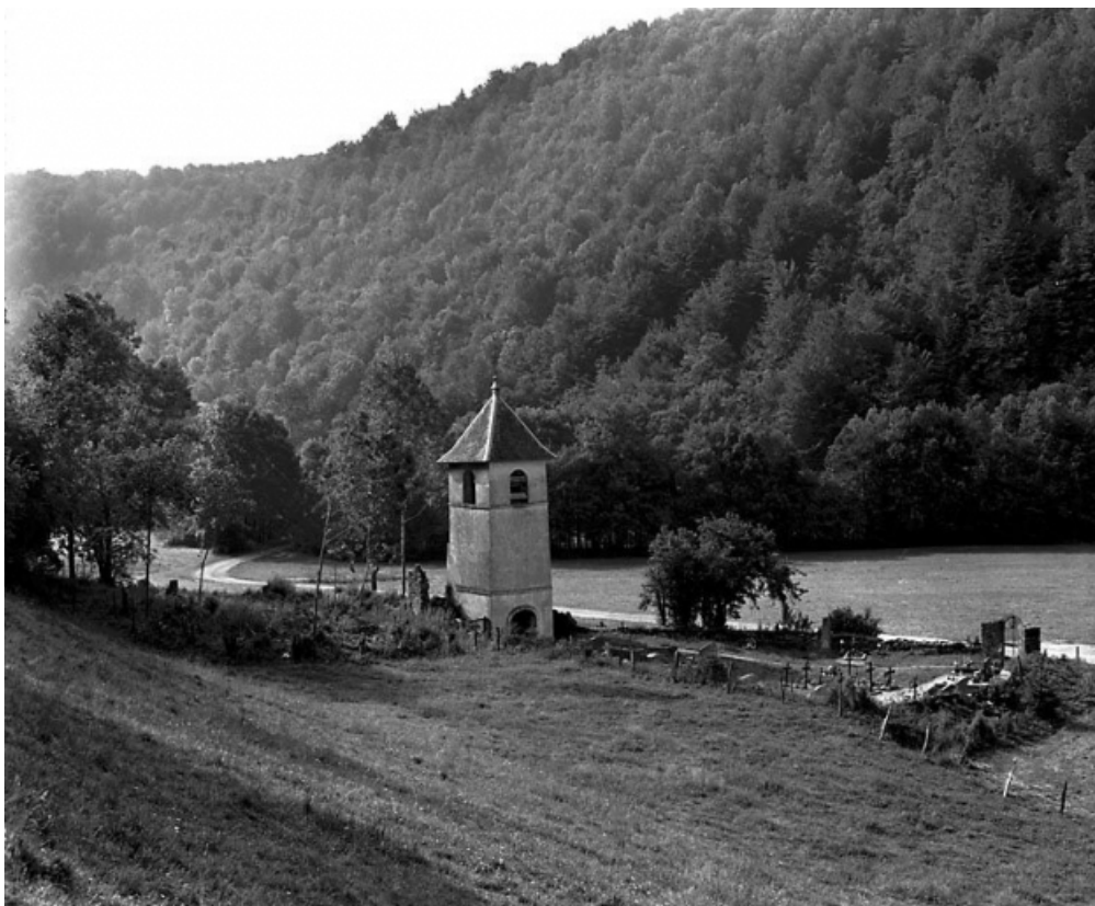
Vue générale depuis le nord-ouest.
