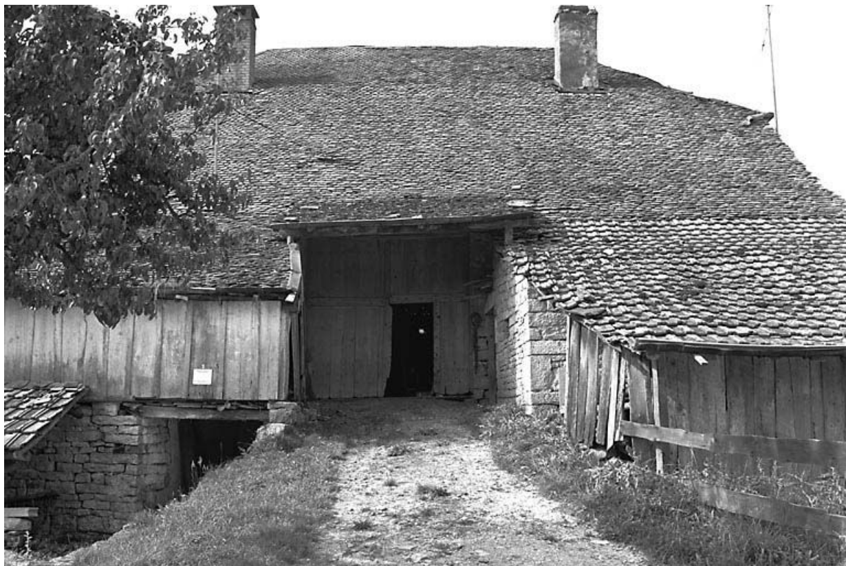
Face latérale droite : entrée de grange.
