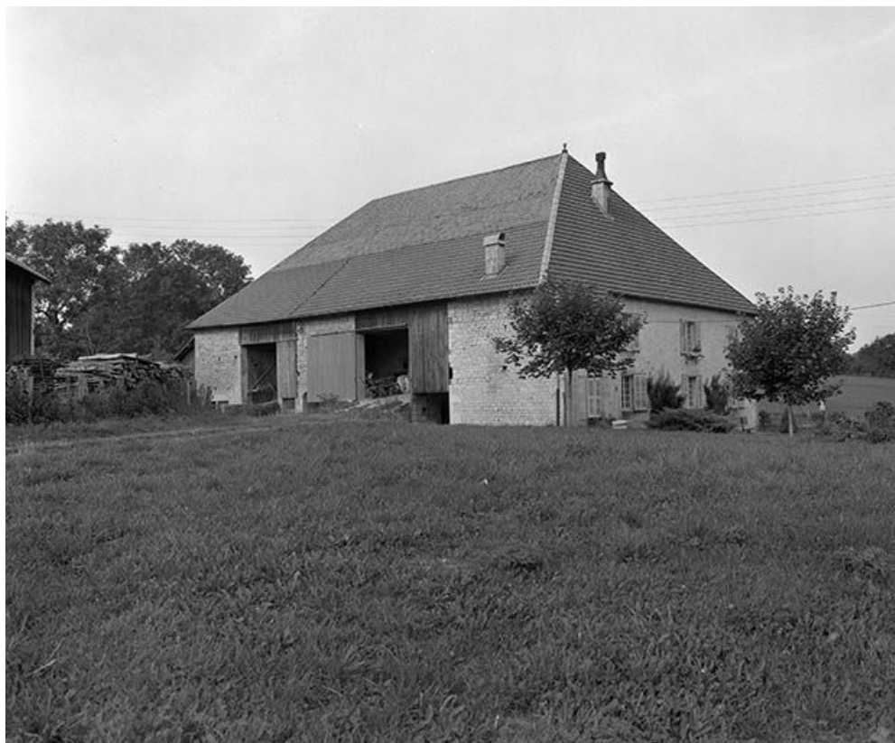
Façade postérieure et face latérale gauche.
