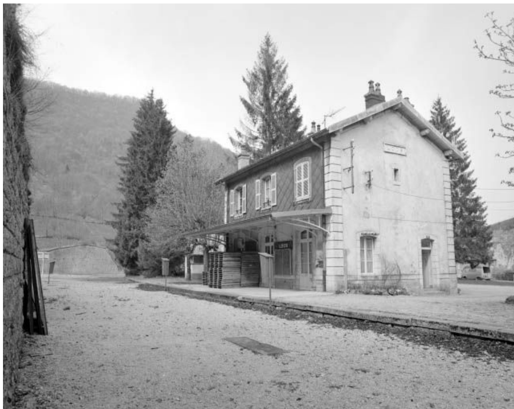
Lods, la gare de voyageurs depuis la voie ferrée. 25, Ornans
