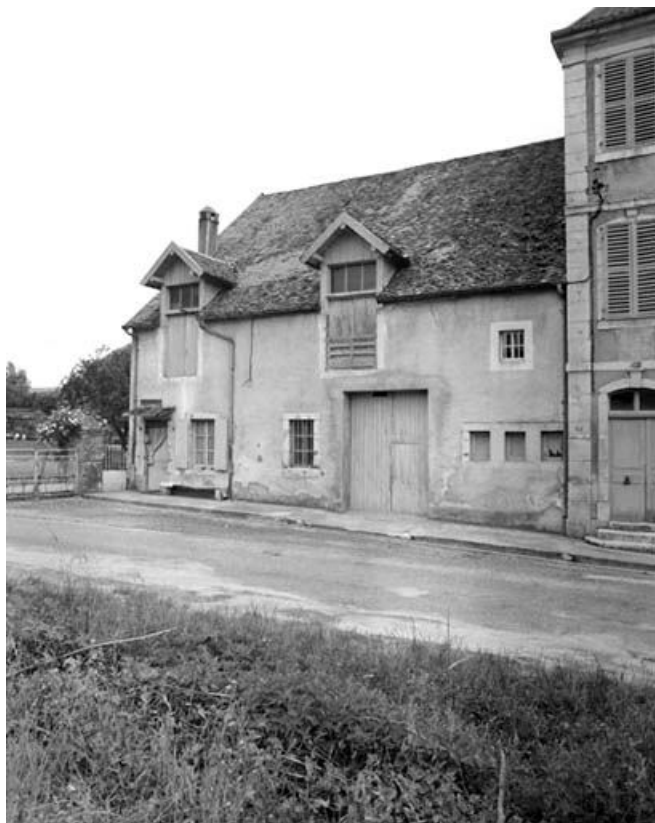
Ferme située 26 rue du Seult.
