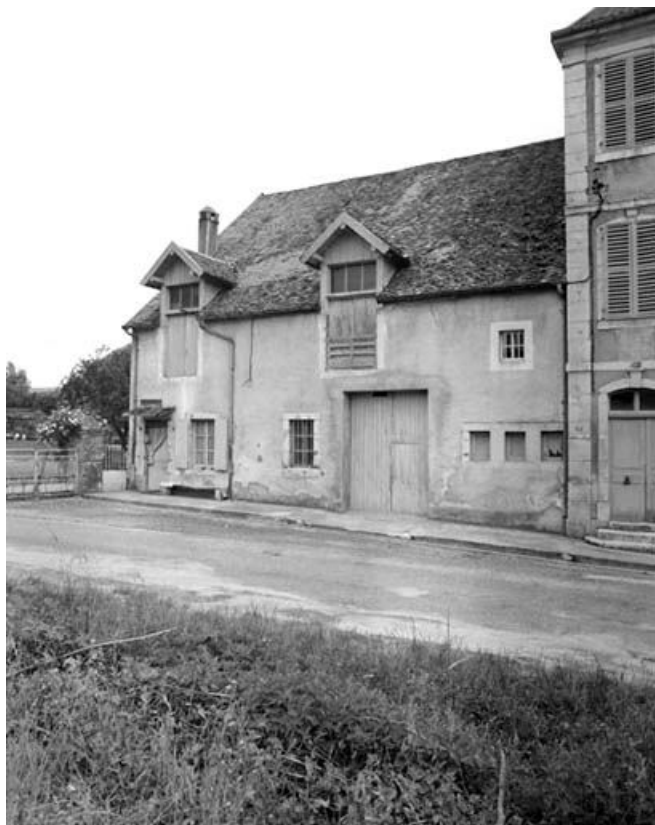
Ferme située 26 rue du Seult.
