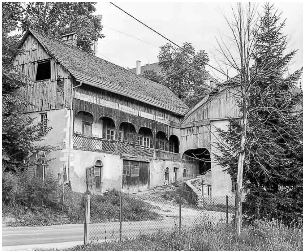
Détail : la galerie.
