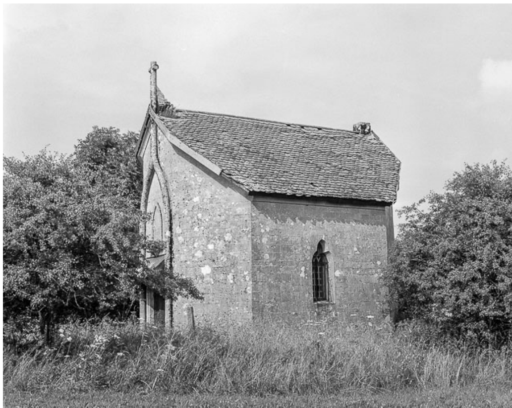
Façade latérale droite.
