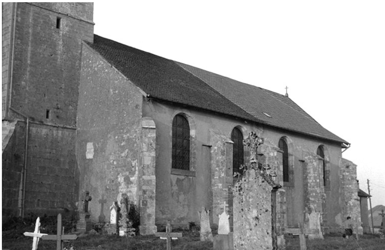
Façade latérale droite et cimetière.
