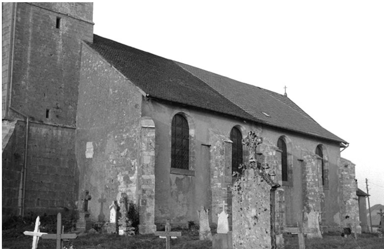
Façade latérale droite et cimetière.
