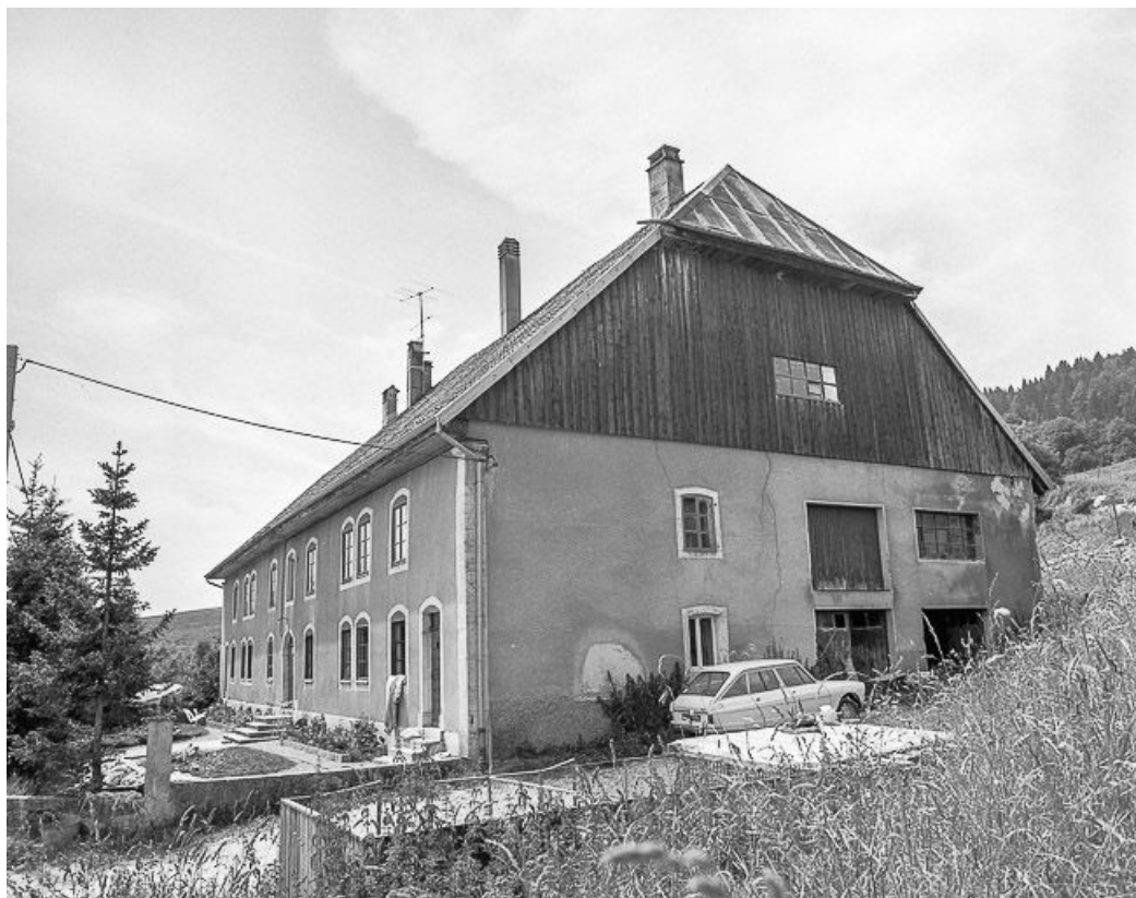
Façades antérieure et latérale droite. 25, Verrières-de-Joux
