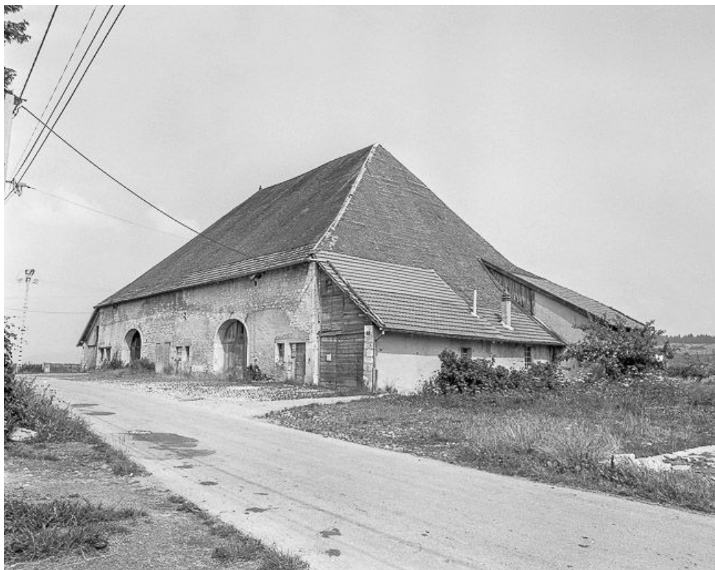
Façade sur rue. 25, Sainte-Colombe
