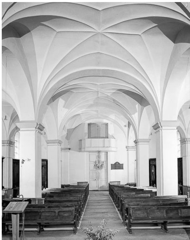
Vue de la nef et de l'entrée depuis le chœur. 25, Sainte-Colombe
