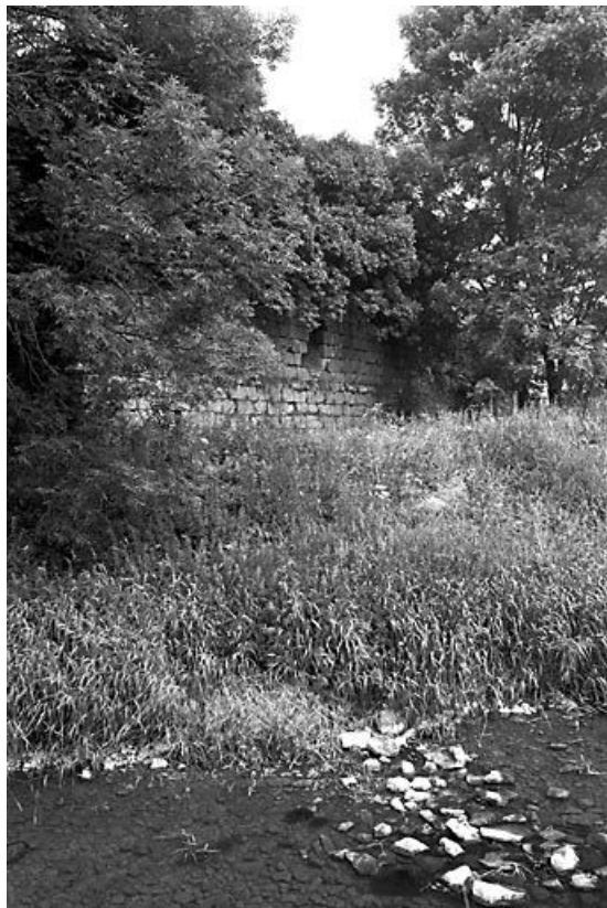
Vestiges du château-fort.
