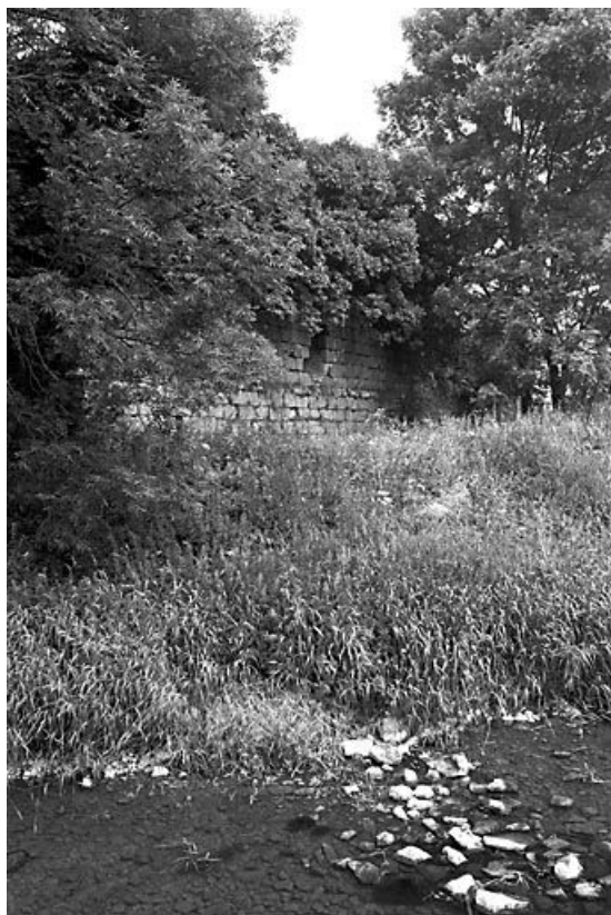
Vestiges du château-fort.
