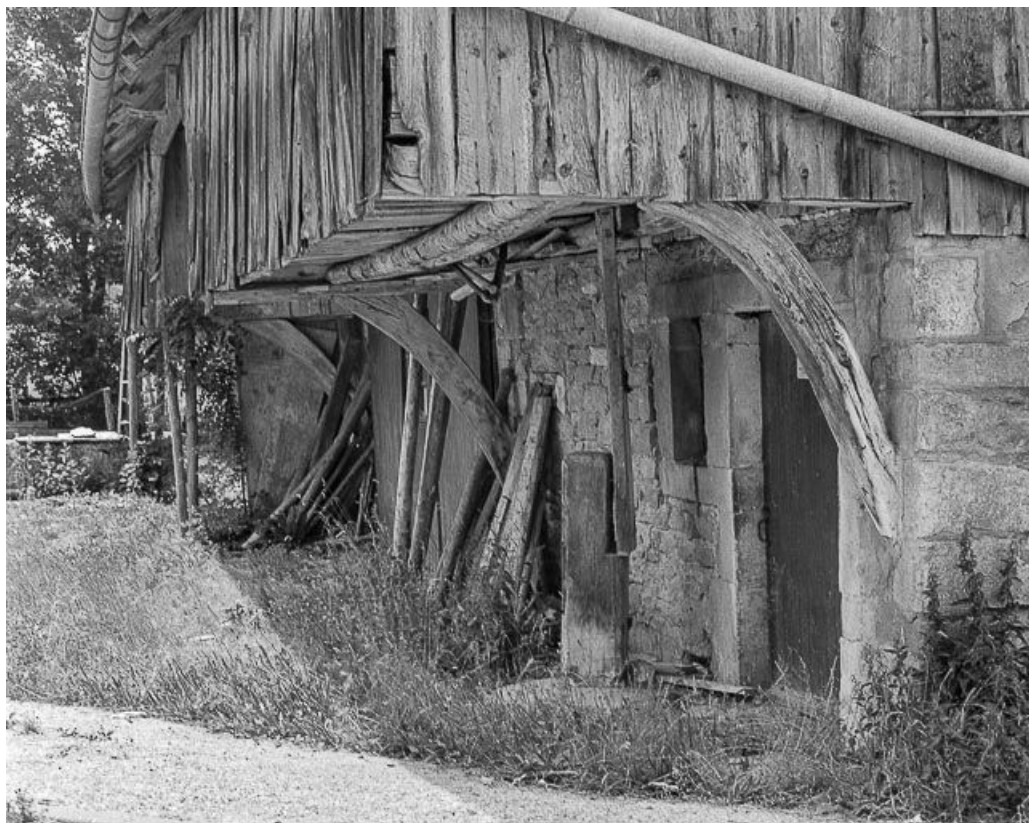
Galerie en bois protégeant un mur goutterot.
