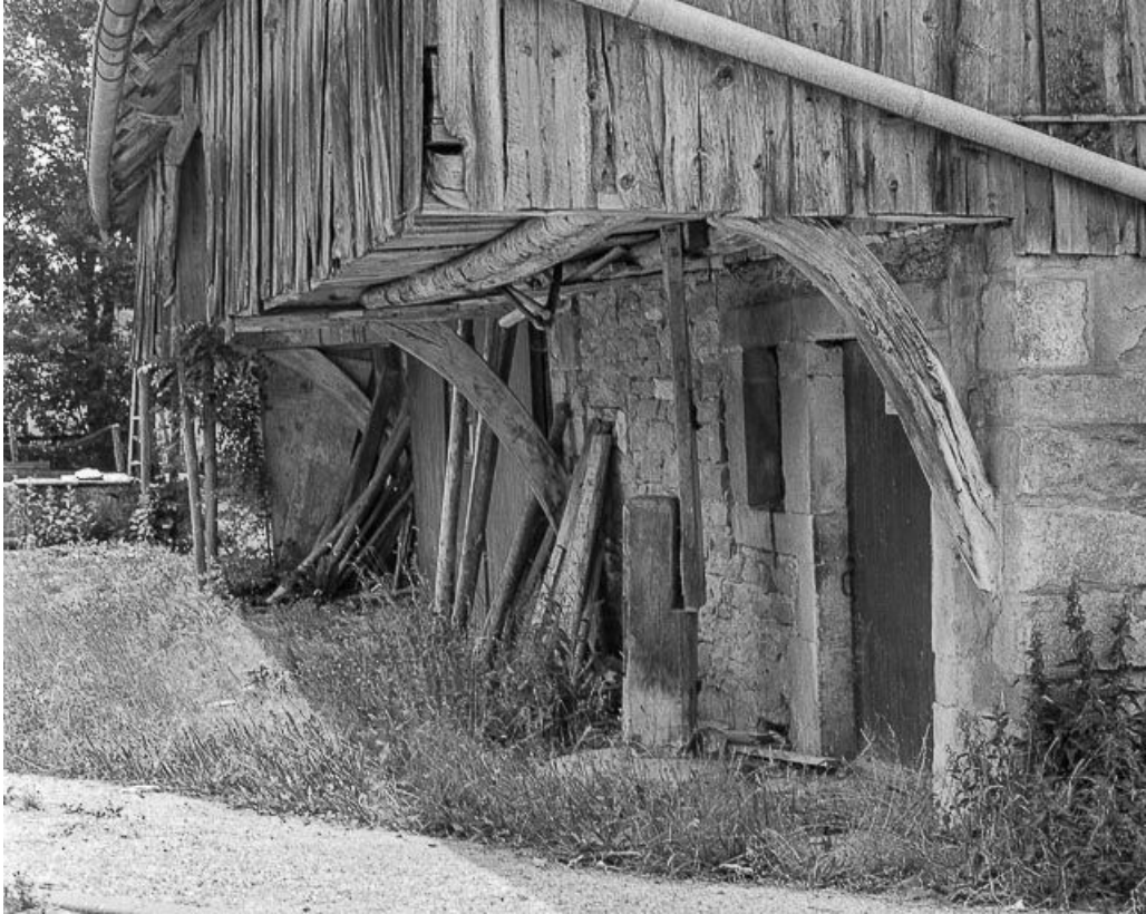
Galerie en bois protégeant un mur goutterot.
