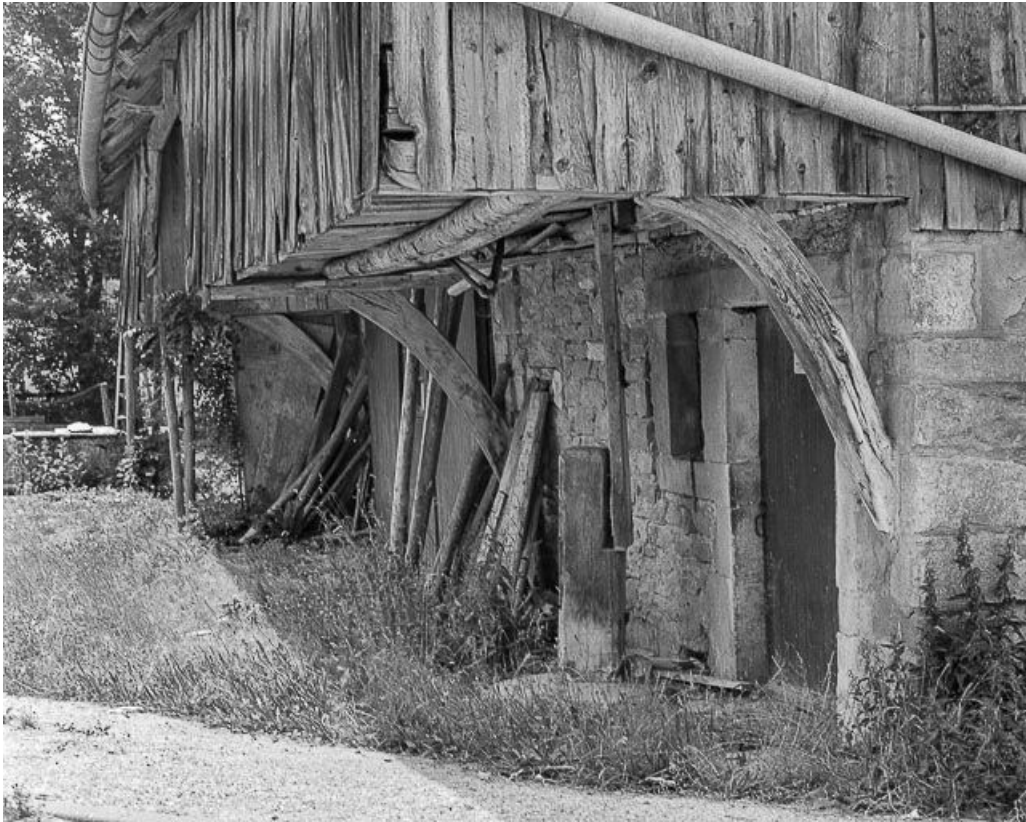
Galerie en bois protégeant un mur goutterot.
