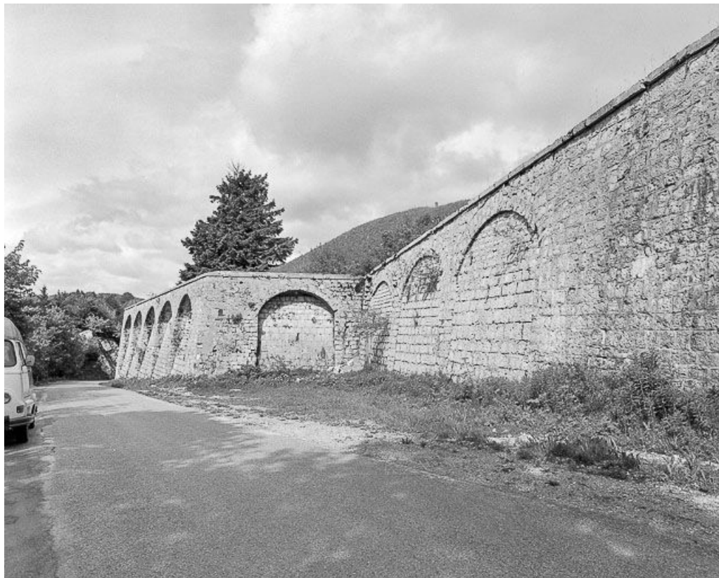
Créneaux de pied défendant l'enceinte : vue éloignée.
