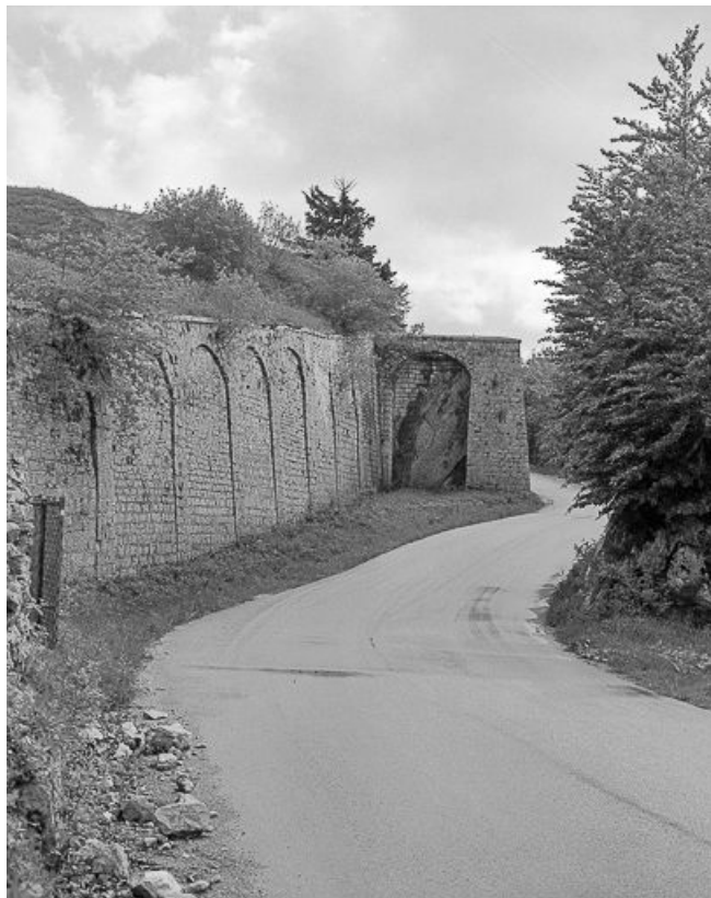
Vue verticale et rapprochée du front de gorge.
