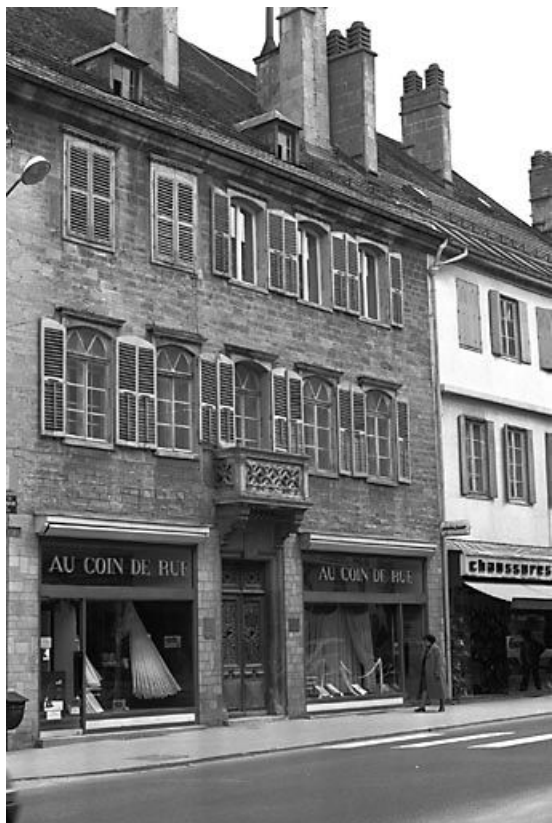
Façade sur rue de trois quarts gauche. 25, Pontarlier, 54 rue de la République
