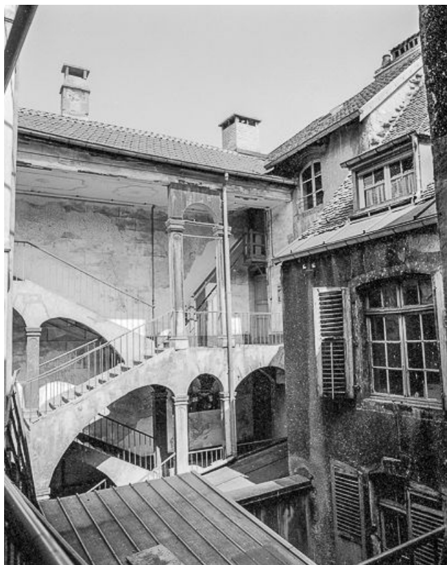
Escalier sur cour intérieure, vue de trois quarts gauche.
