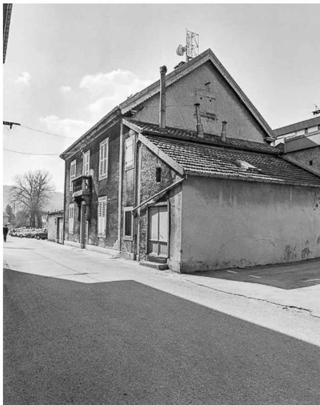
Façades sur rue et latérale droite.
