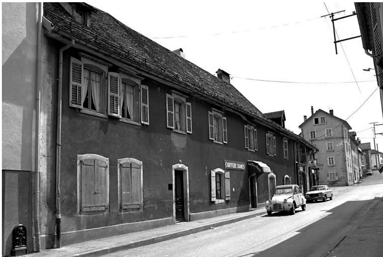
Façade sur rue de trois quarts gauche. 25, Pontarlier, 31, 35 rue Montrieux
