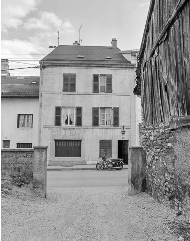
Façade sur rue, vue de face.
