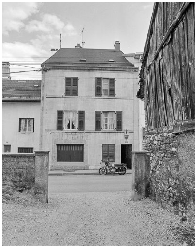
Façade sur rue, vue de face. 25, Pontarlier
