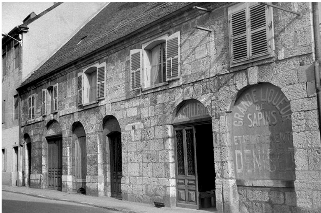
Façade ouest en 1968.
