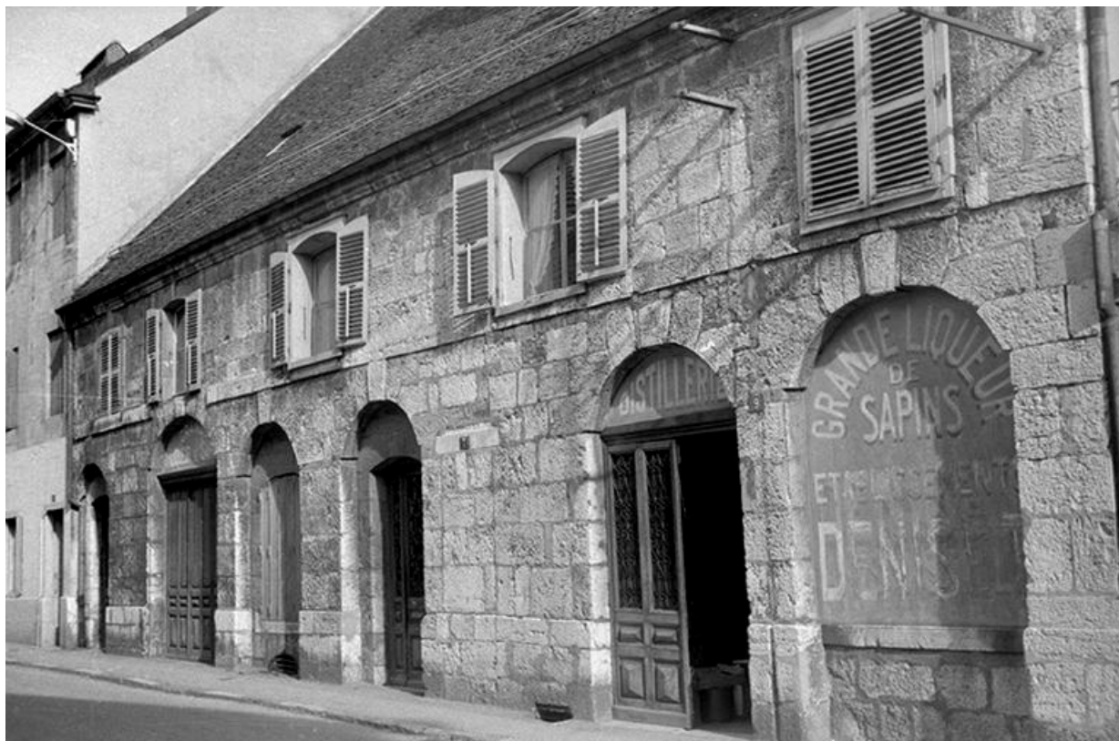
Façade ouest en 1968.
