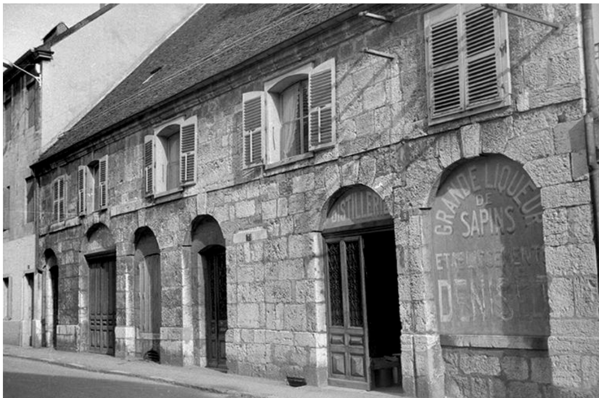
Façade ouest en 1968.
