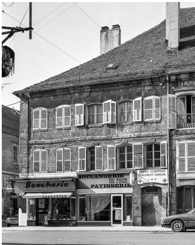
Façade sur rue de la République, vue de face. 25, Pontarlier, 2 rue Montrieux
