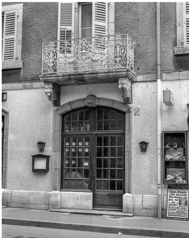
Porte d'entrée sur rue de la Gare.
