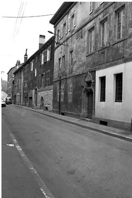
Façade sur la rue Gambetta. 25, Pontarlier, 21 rue Gambetta
