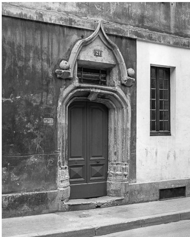
Détail : porte d'entrée, de trois quarts gauche.
