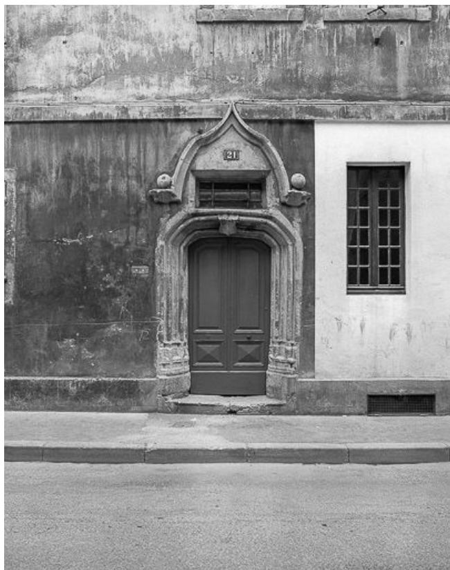
Détail : porte d'entrée, vue de face.
