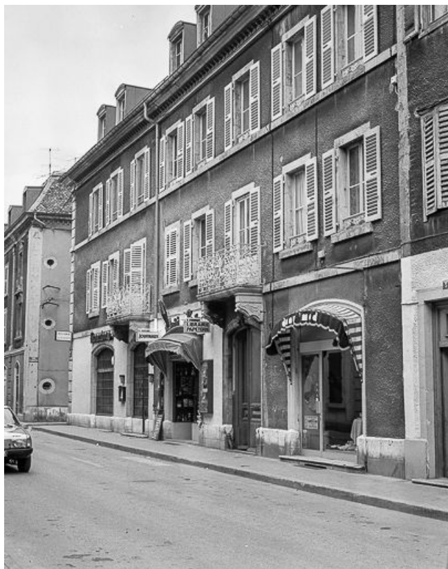
Façade sur rue de la Gare.
