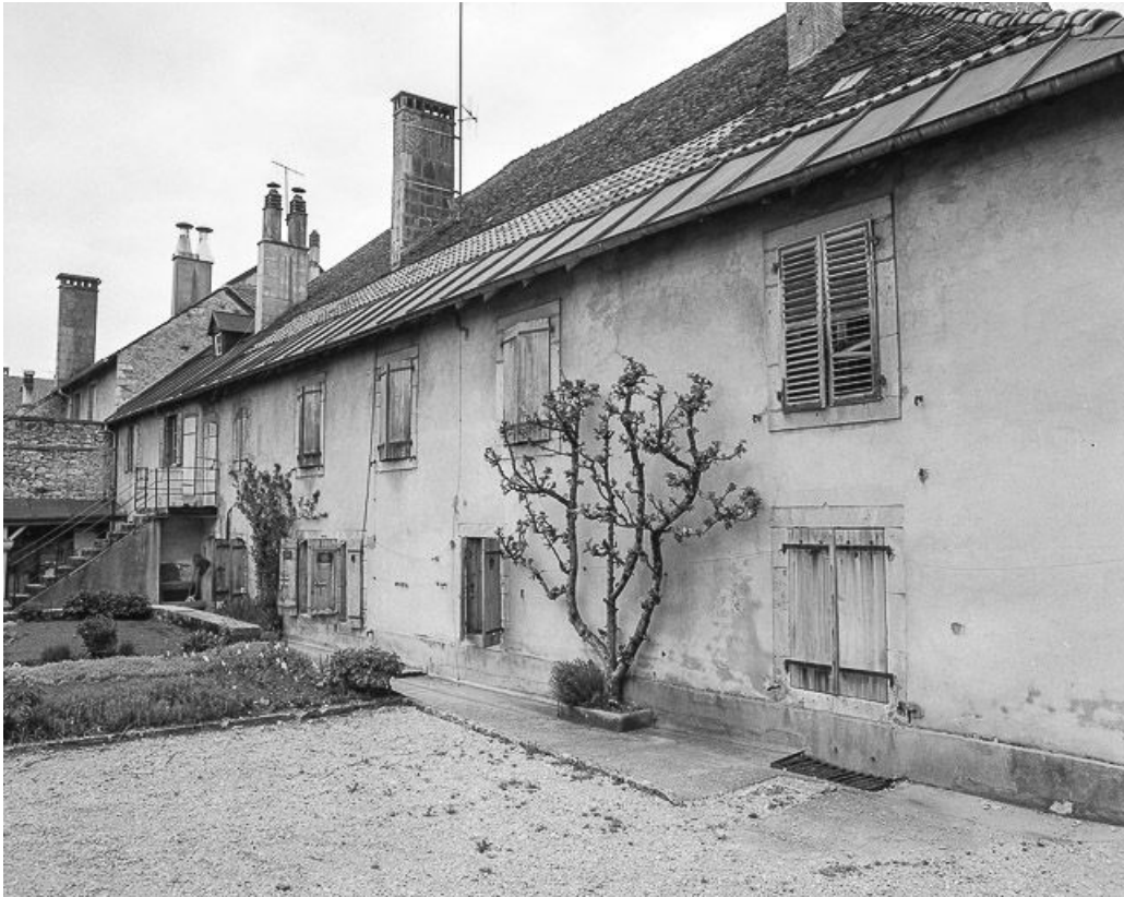
Façade postérieure (habitation).
