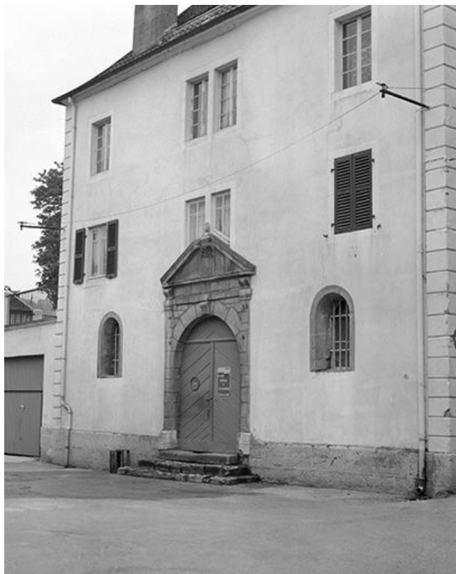
Façade sur la rue Jeanne d'Arc.
