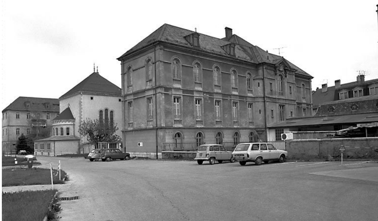
Façade postérieure, vue d'ensemble de trois quarts.
