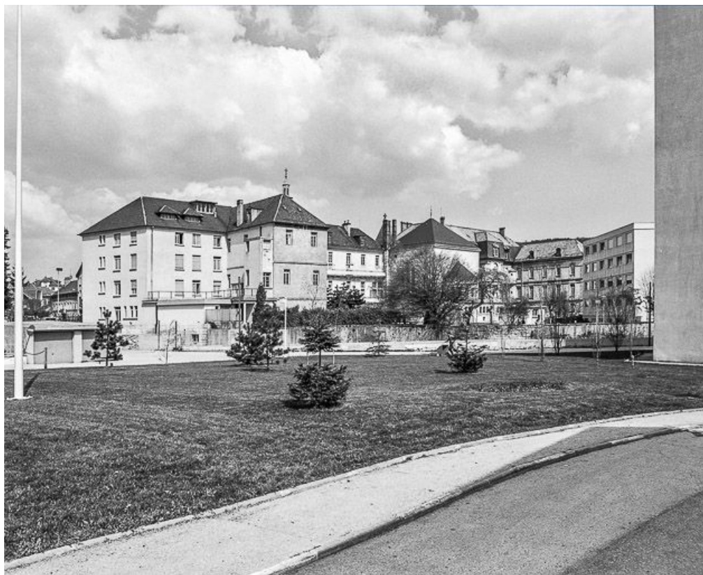
Façade postérieure. Vue d'ensemble de trois quarts gauche.
