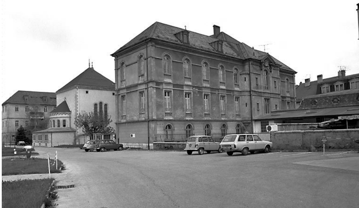
Façade postérieure, vue d'ensemble de trois quarts.
