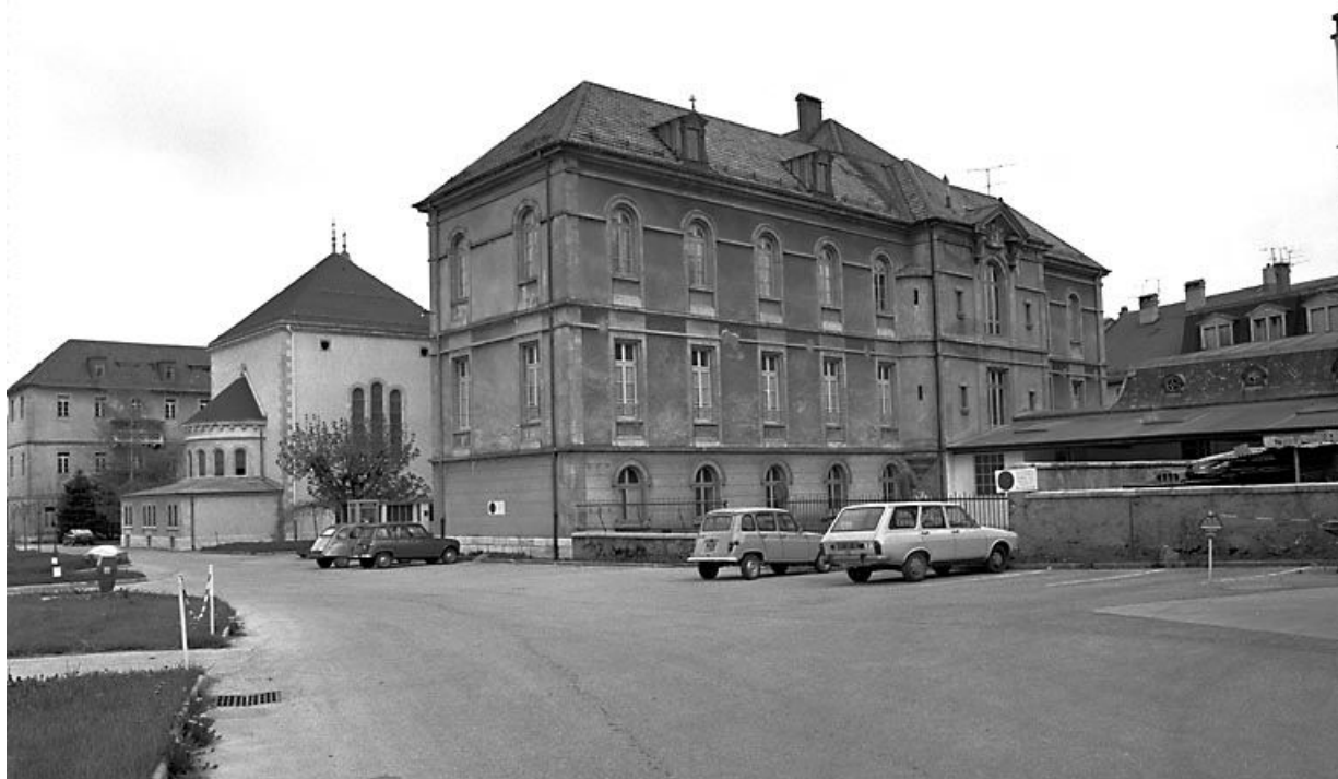
Façade postérieure, vue d'ensemble de trois quarts.
