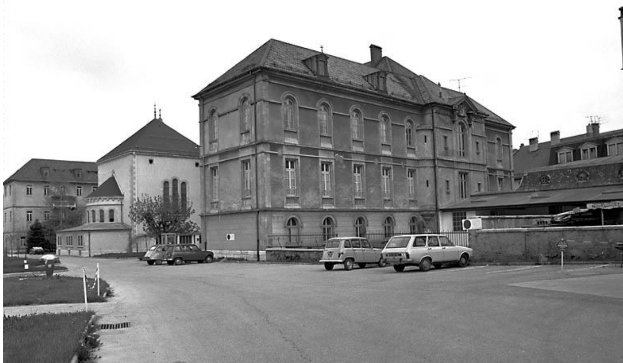
Façade postérieure, vue d'ensemble de trois quarts.
