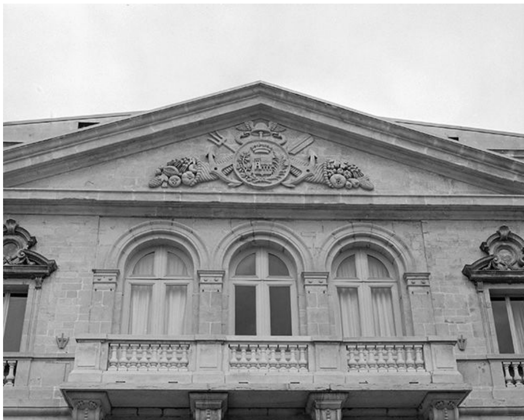
Façade antérieure. Corps central, fenêtre et fronton.
