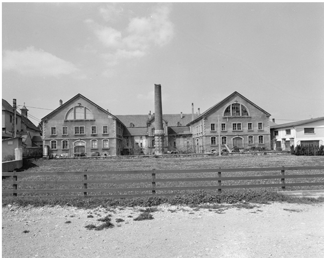
Façade postérieure vue de face.
