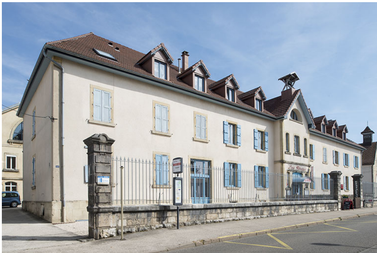
Vue de trois quarts droite du bâtiment de distillerie.
