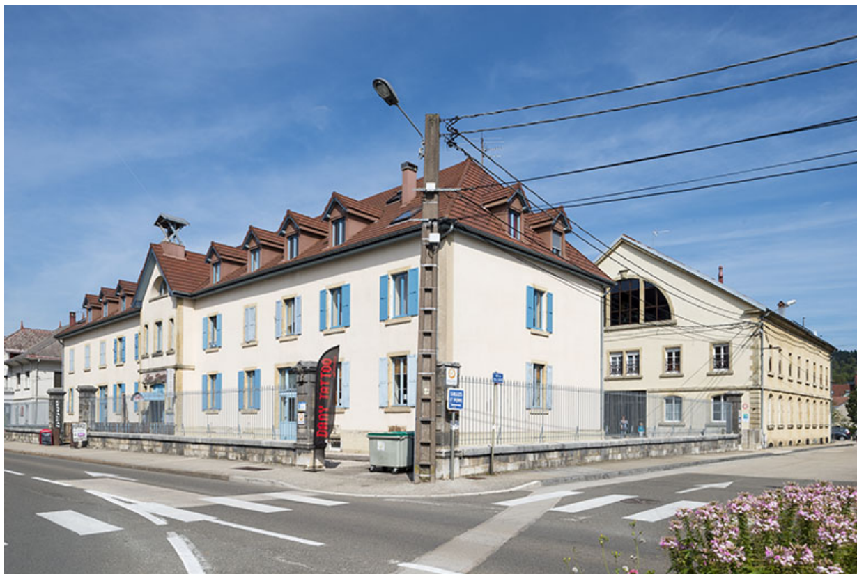
Vue d'ensemble depuis le sud. 25, Pontarlier
