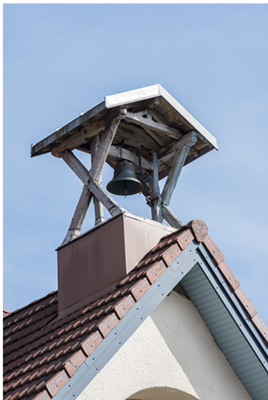
Bâtiment de distillerie. Campanile sur le corps central. 25, Pontarlier, 34-36 rue de Besançon
