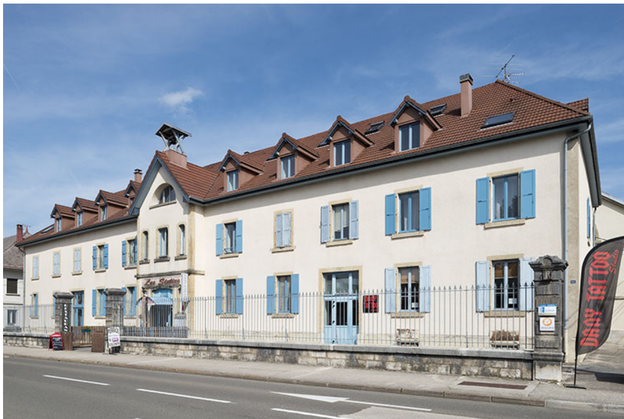
Le bâtiment de la distillerie vu de trois quarts droite.
