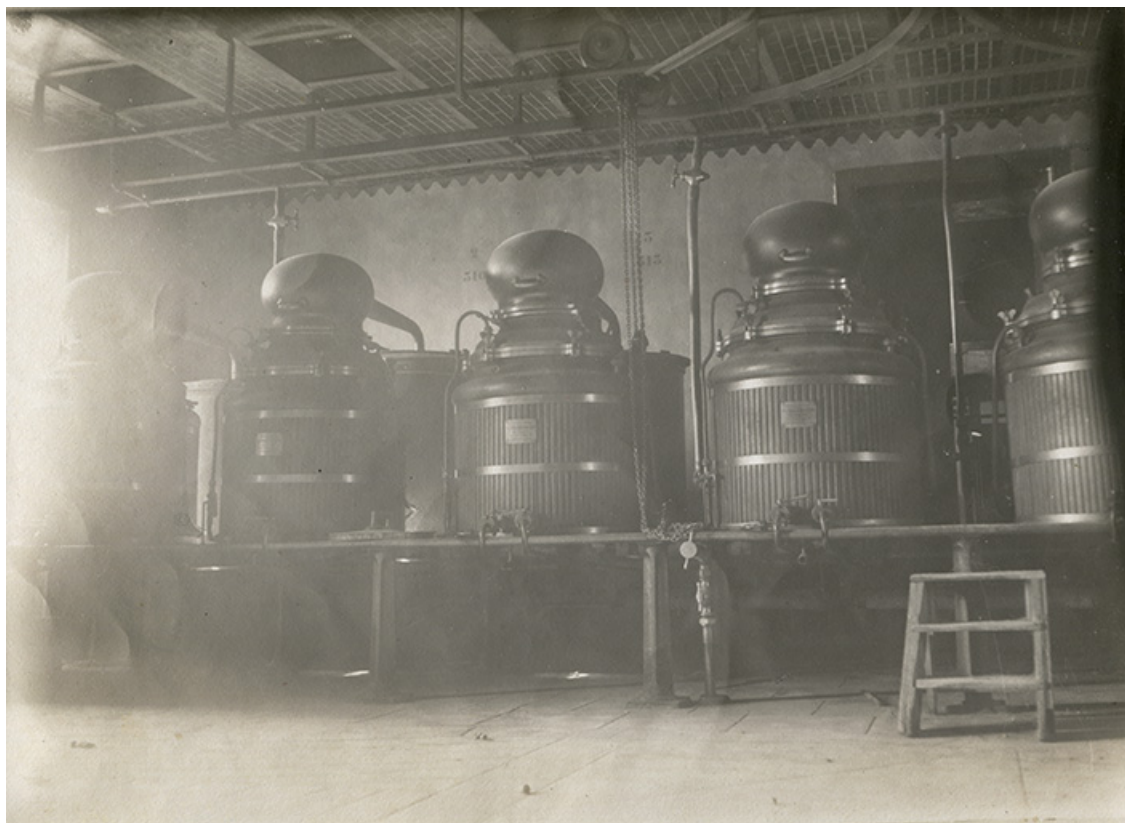
Batterie d'alambics, fotogr., s.d. [début 20e siècle].
