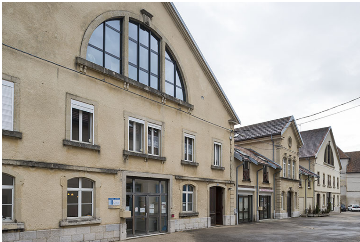
Façade ouest des chais et entrepôts. Vue de trois quarts gauche.
