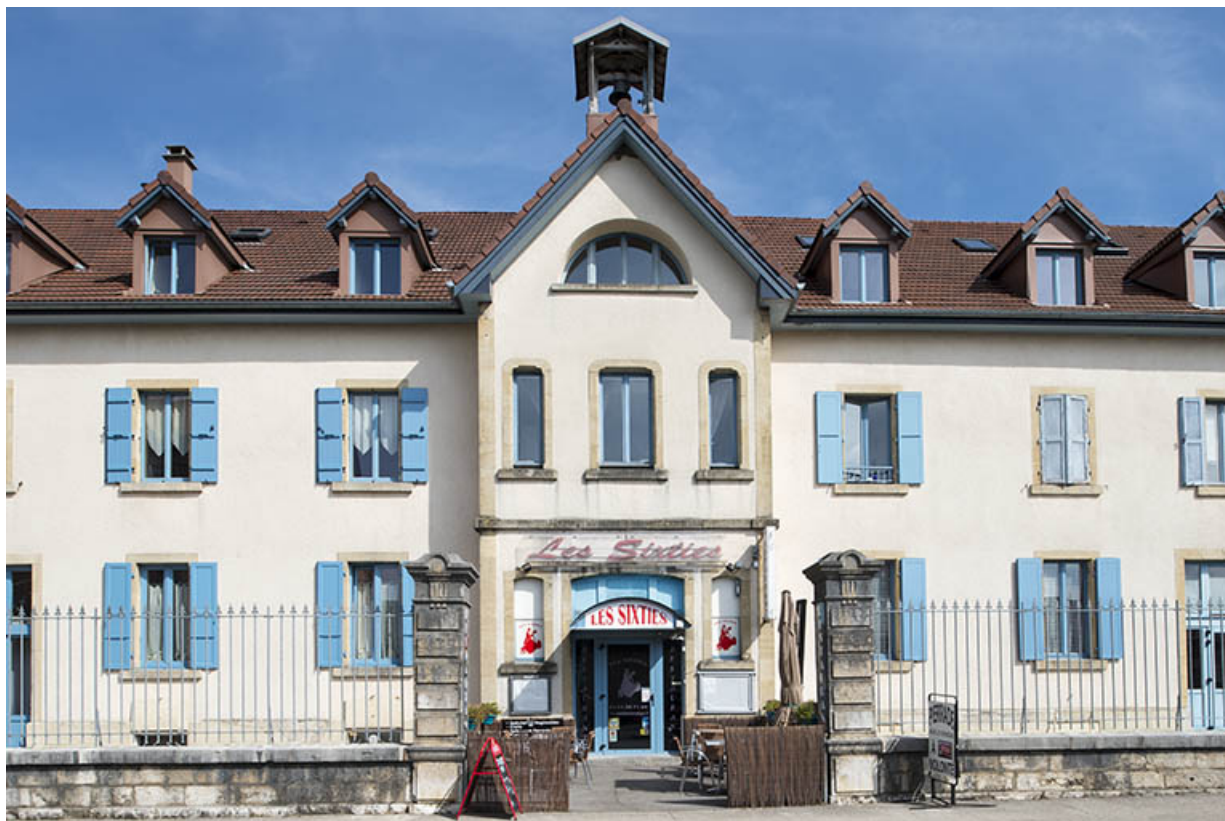
Partie centrale du bâtiment de la distillerie.
