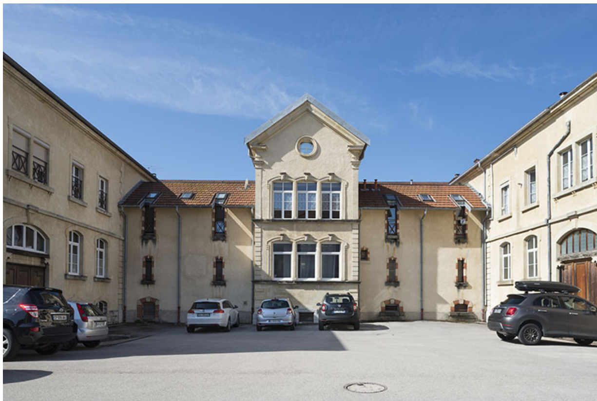
Vue axiale depuis la cour nord.
