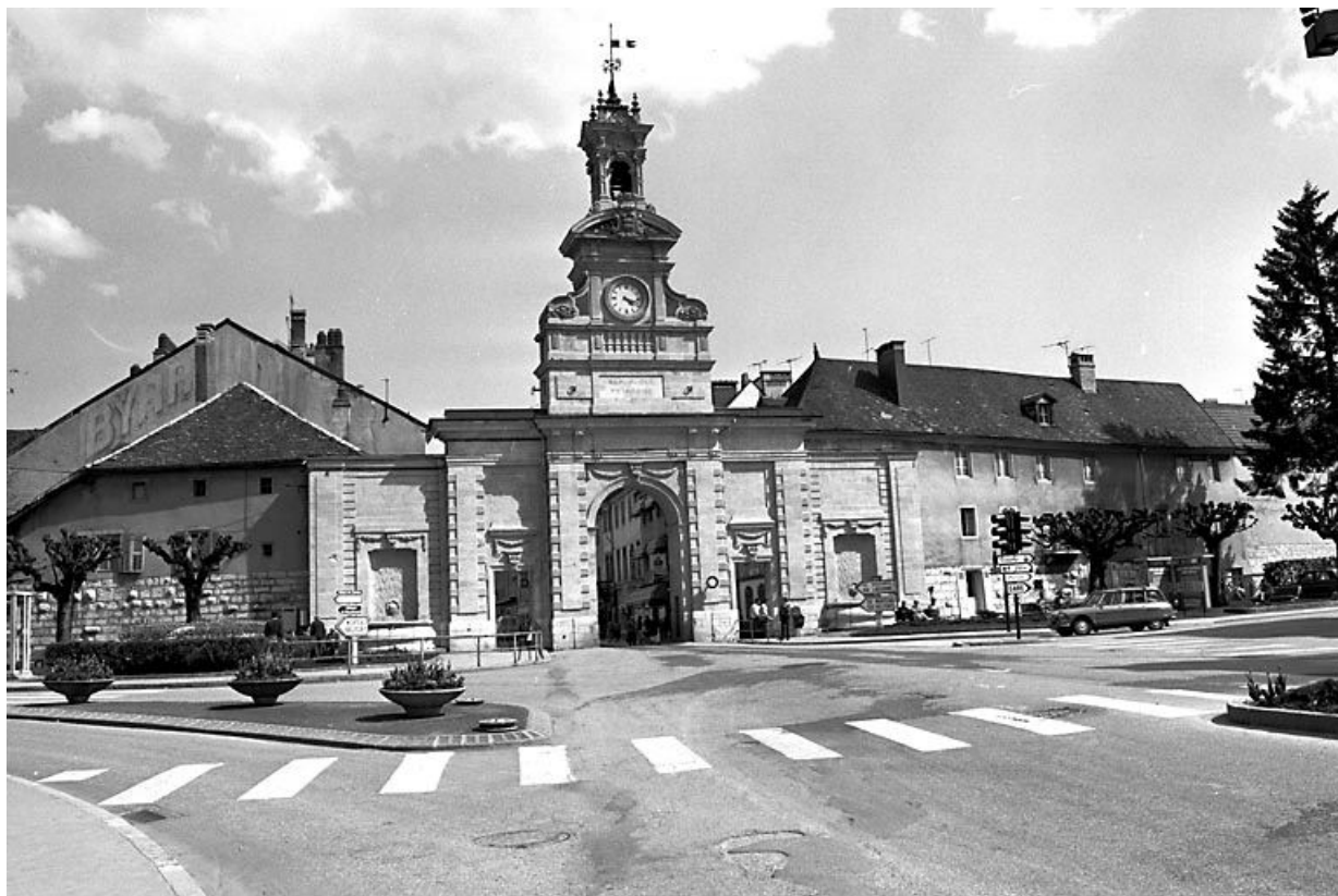
Vue d'ensemble depuis la place Saint-Pierre.
