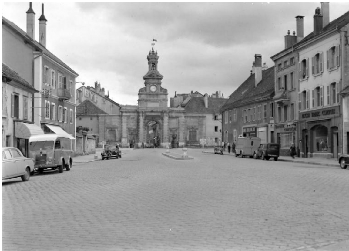
Vue depuis la rue de Salins [1e moitié du 20e siècle]. 25, Pontarlier place Saint-Pierre
