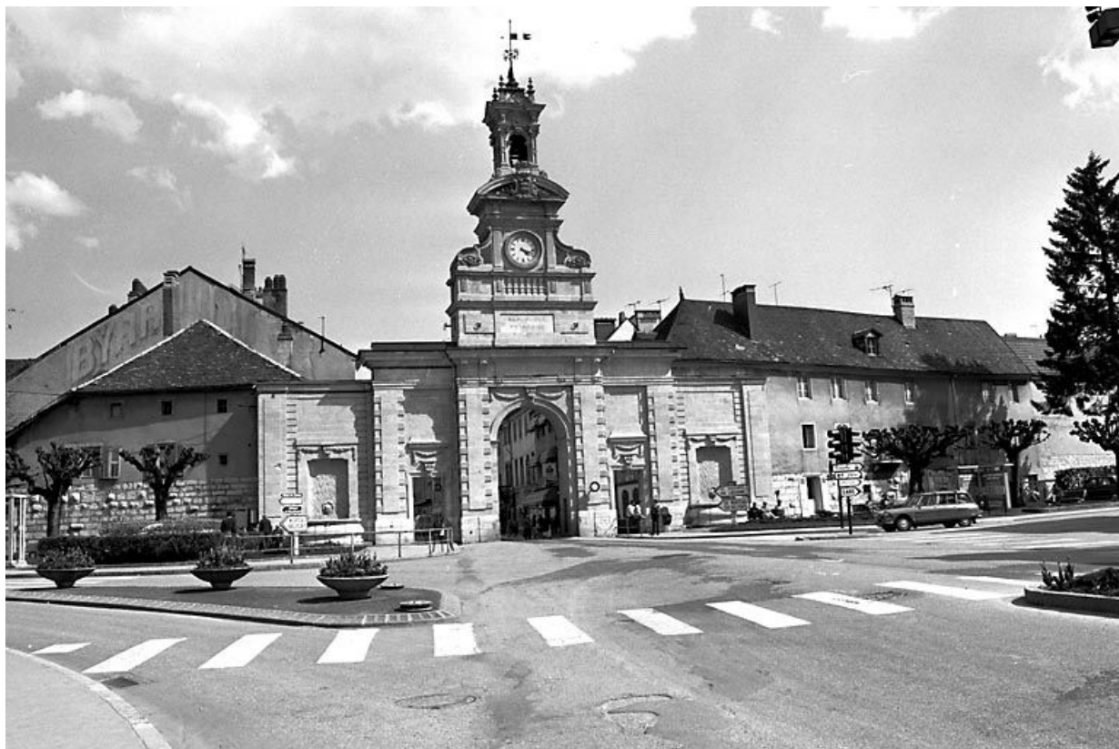
Vue d'ensemble depuis la place Saint-Pierre.
