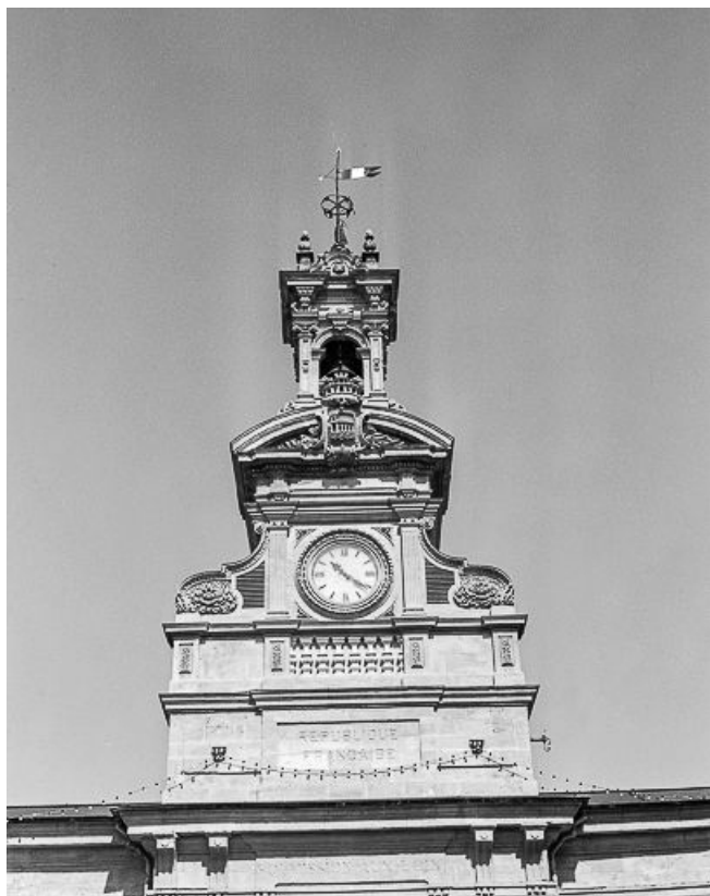
Partie supérieure, vue de face.
