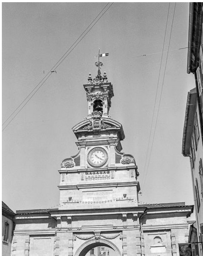
Vue de la partie supérieure et de l'arcade centrale depuis la rue de la République. 25, Pontarlier place Saint-Pierre
