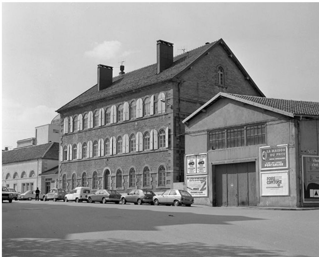
Façade sur rue, vue de trois quarts droit.
