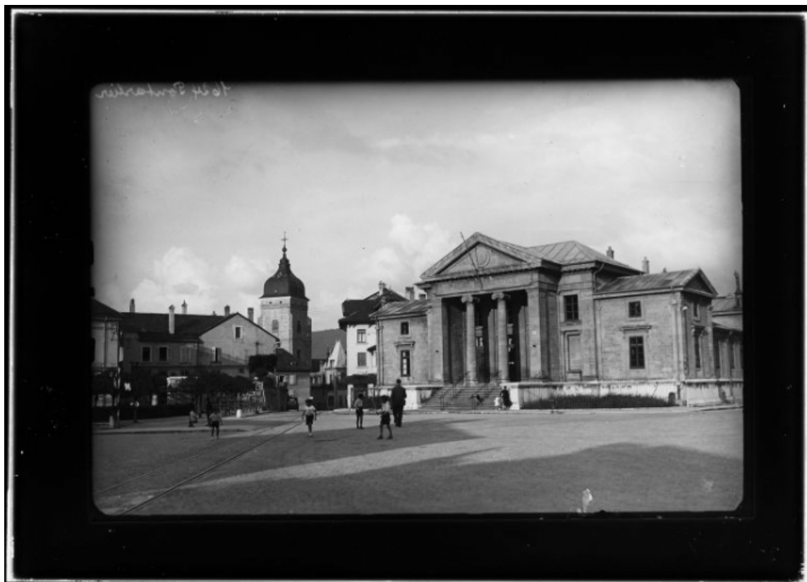
Vue d'ensemble [1re moitié 20e siècle]. 25, Pontarlier, 1 place de la Gare
