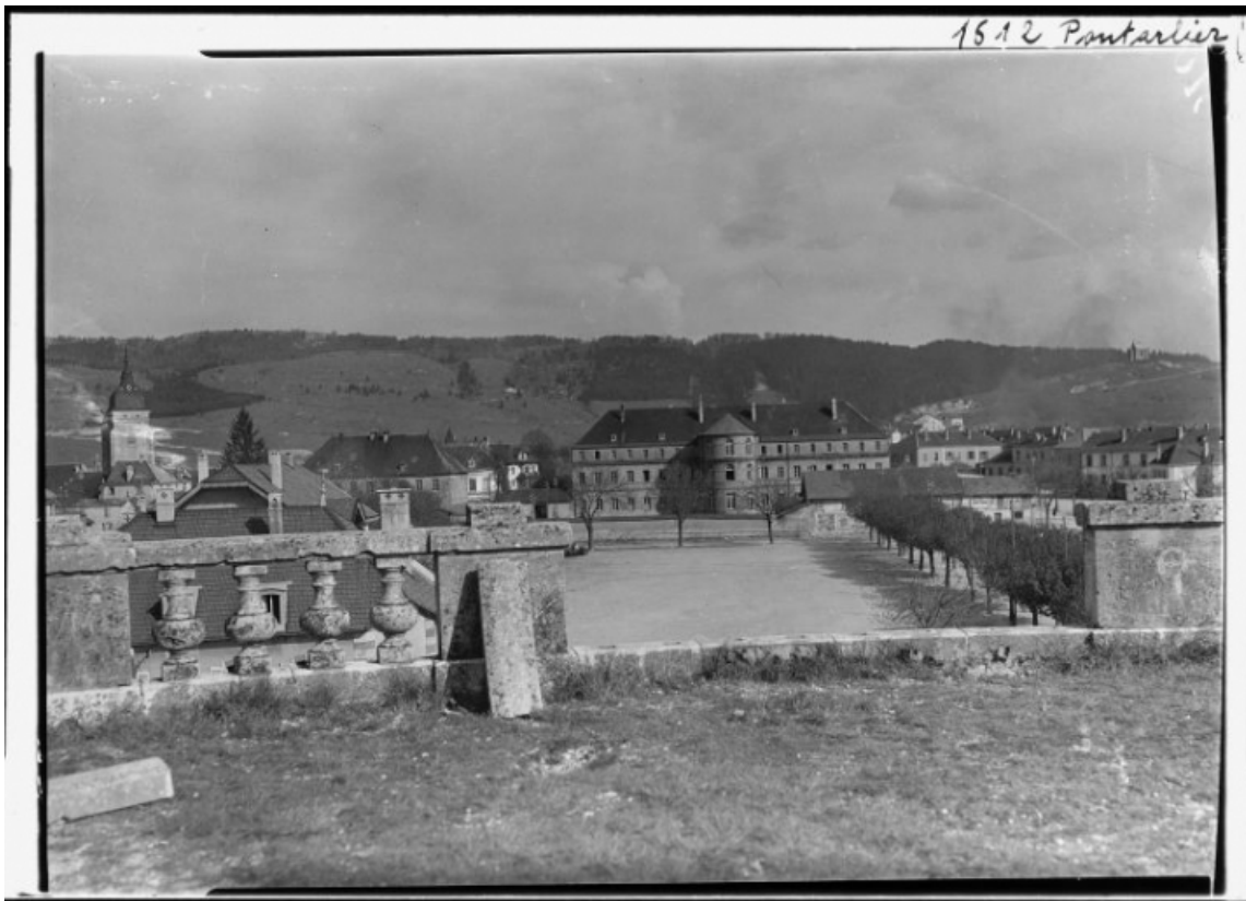
Façade sur la cour [1re moitié 20e siècle].
