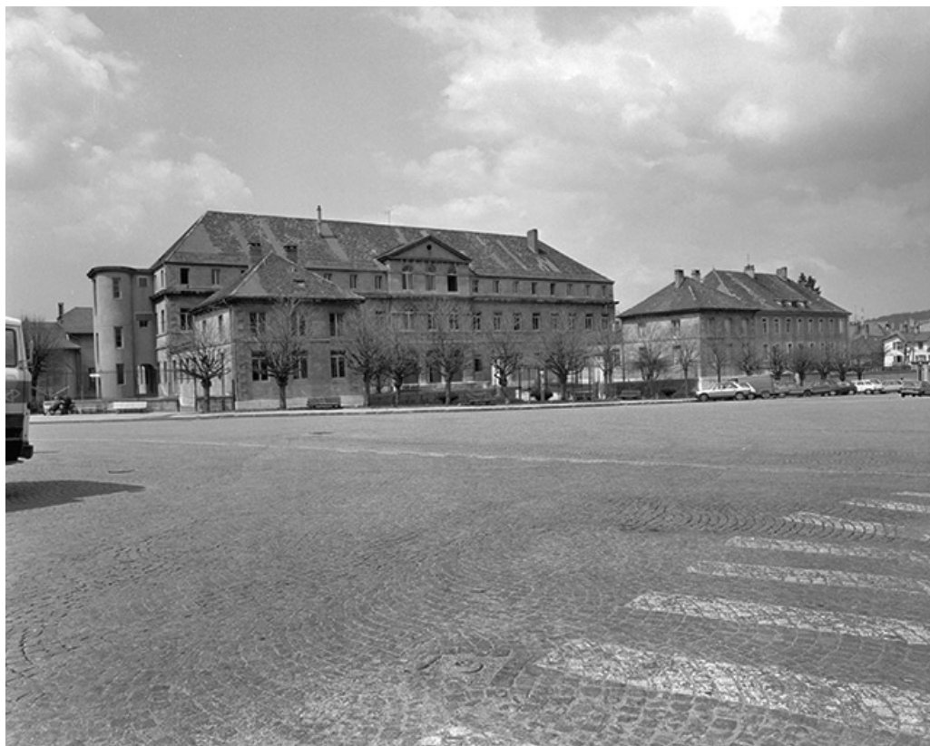
Façade antérieure, vue de trois quarts gauche.
