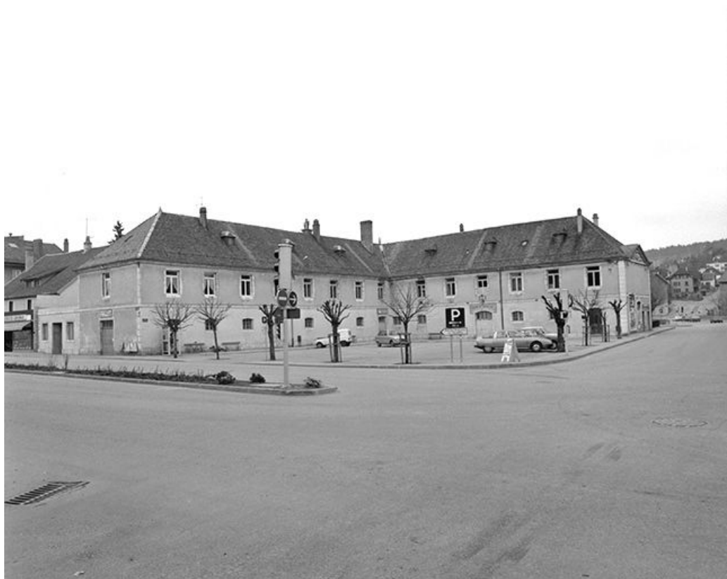
Corps de bâtiment gauche.
