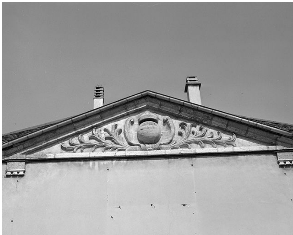
Fronton de pignon sur rue.
