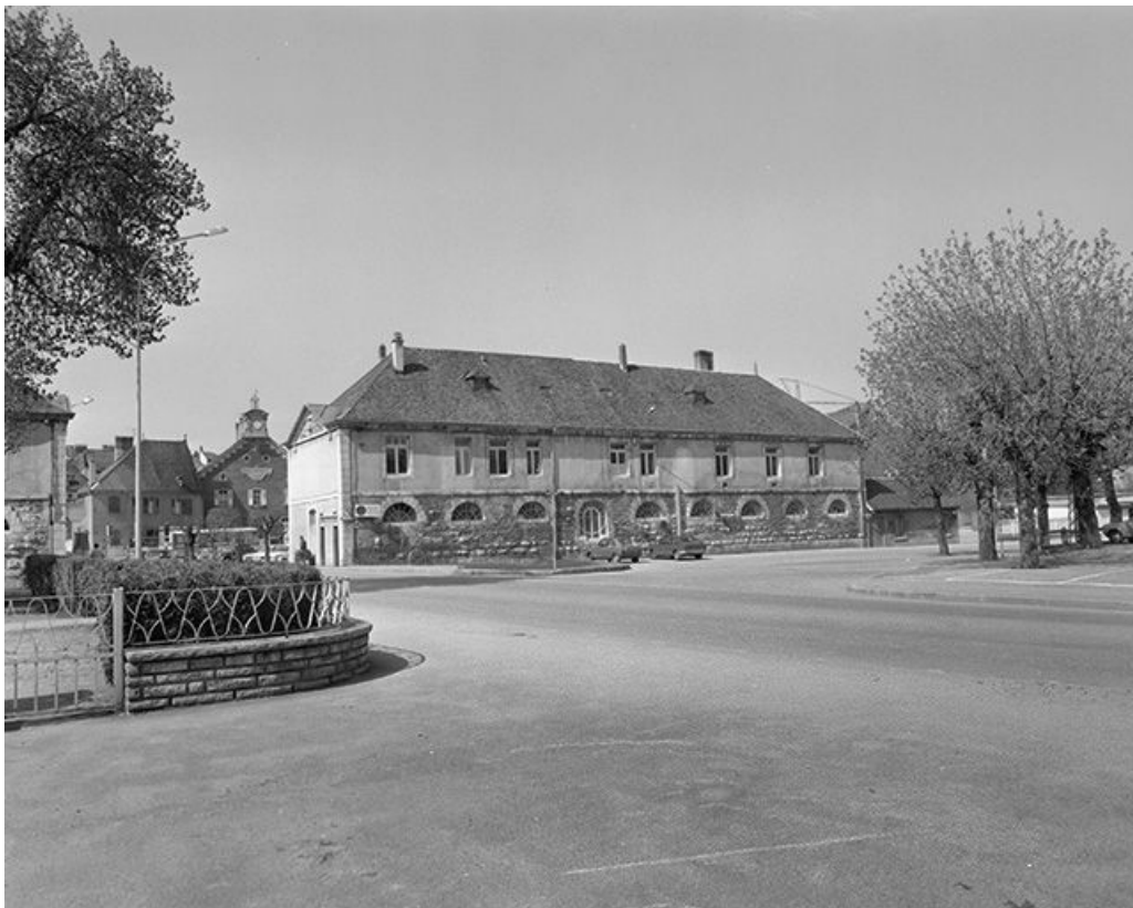
Façade postérieure : corps de bâtiment gauche sur l'ancien canal.
