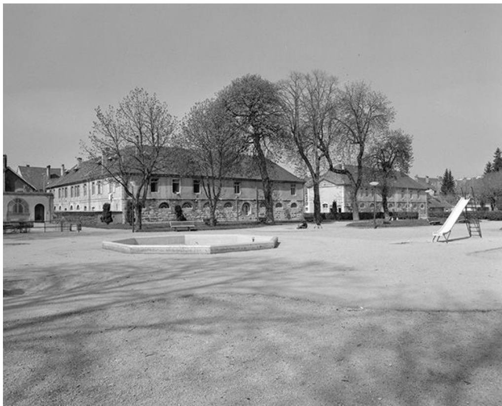
Vue d'ensemble de la façade postérieure.
