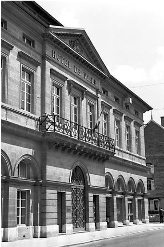
Façade sur la rue de la République. 25, Pontarlier
