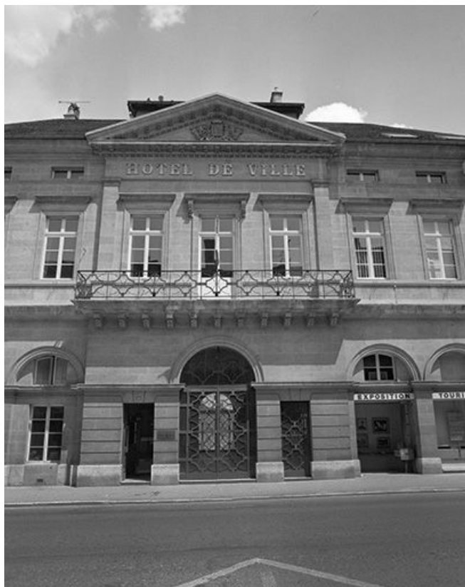
Façade antérieure, partie centrale.
