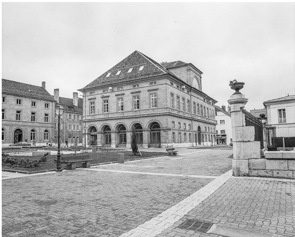
Façade postérieure et façade latérale droite.
