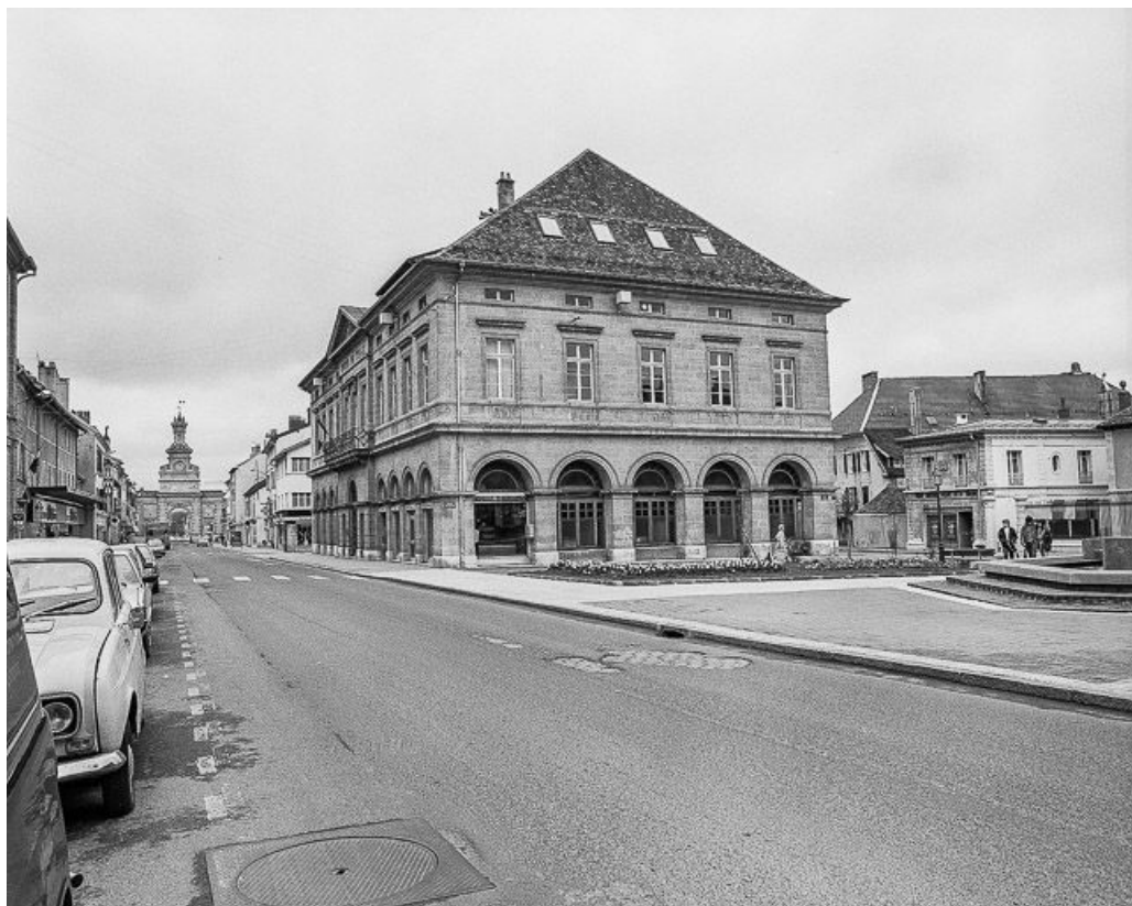
Façade antérieure et façade latérale droite.
