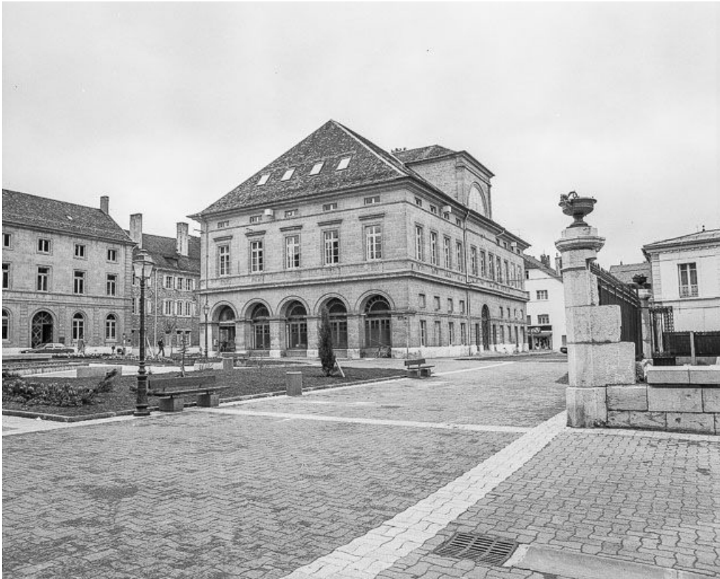
Façade postérieure et façade latérale droite.
