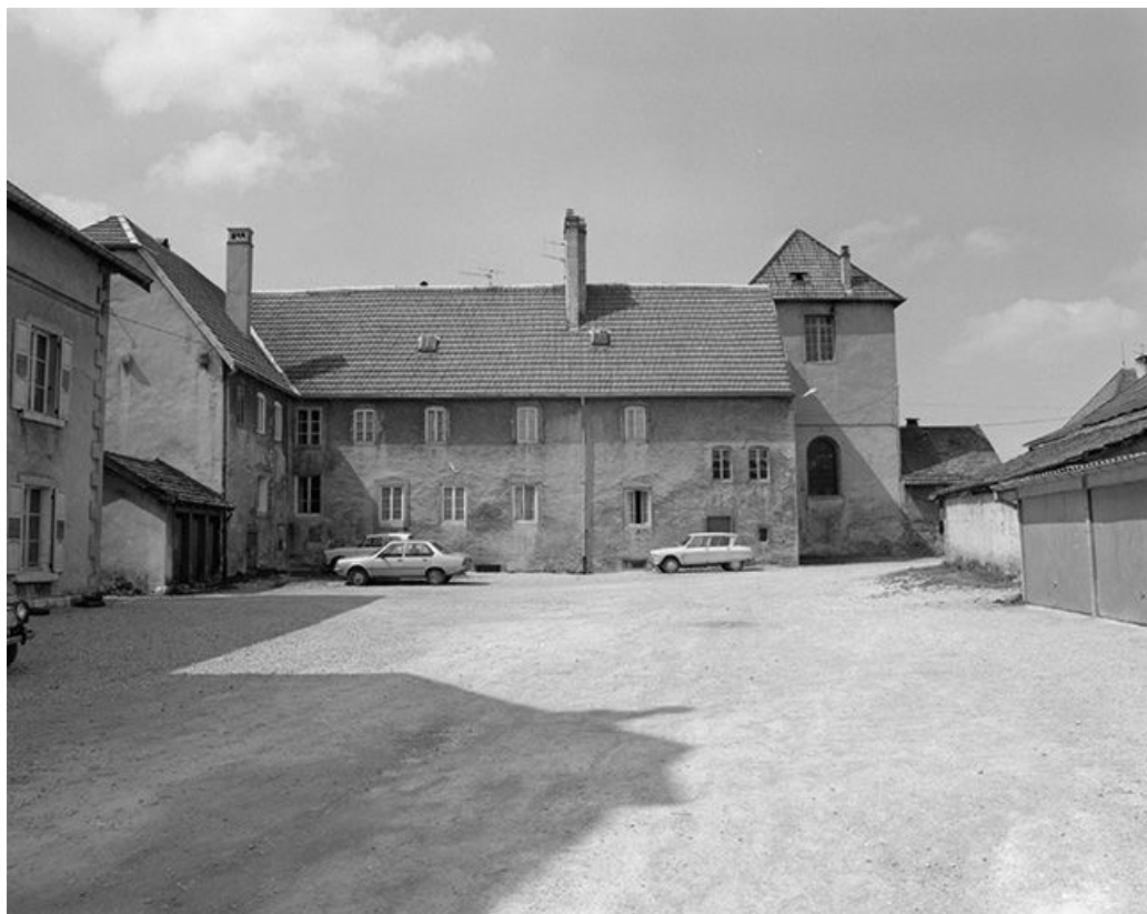
Façade extérieure d'un corps de bâtiment conventuel.
