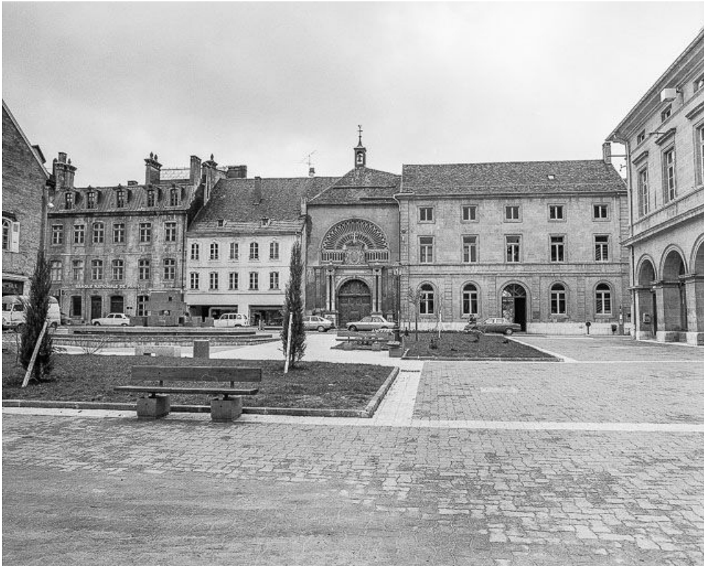
Vue d'ensemble de la chapelle.
