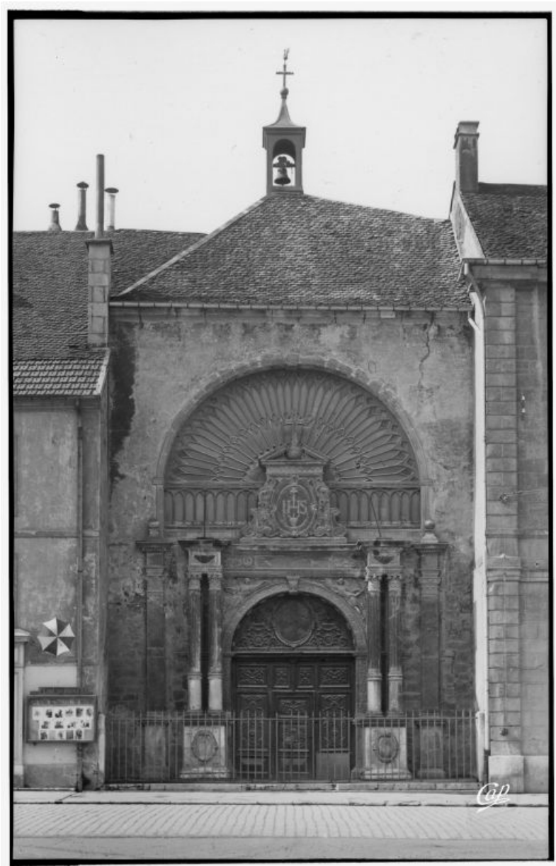
Portail d'entrée de la chapelle [1re moitié 20e siècle].
