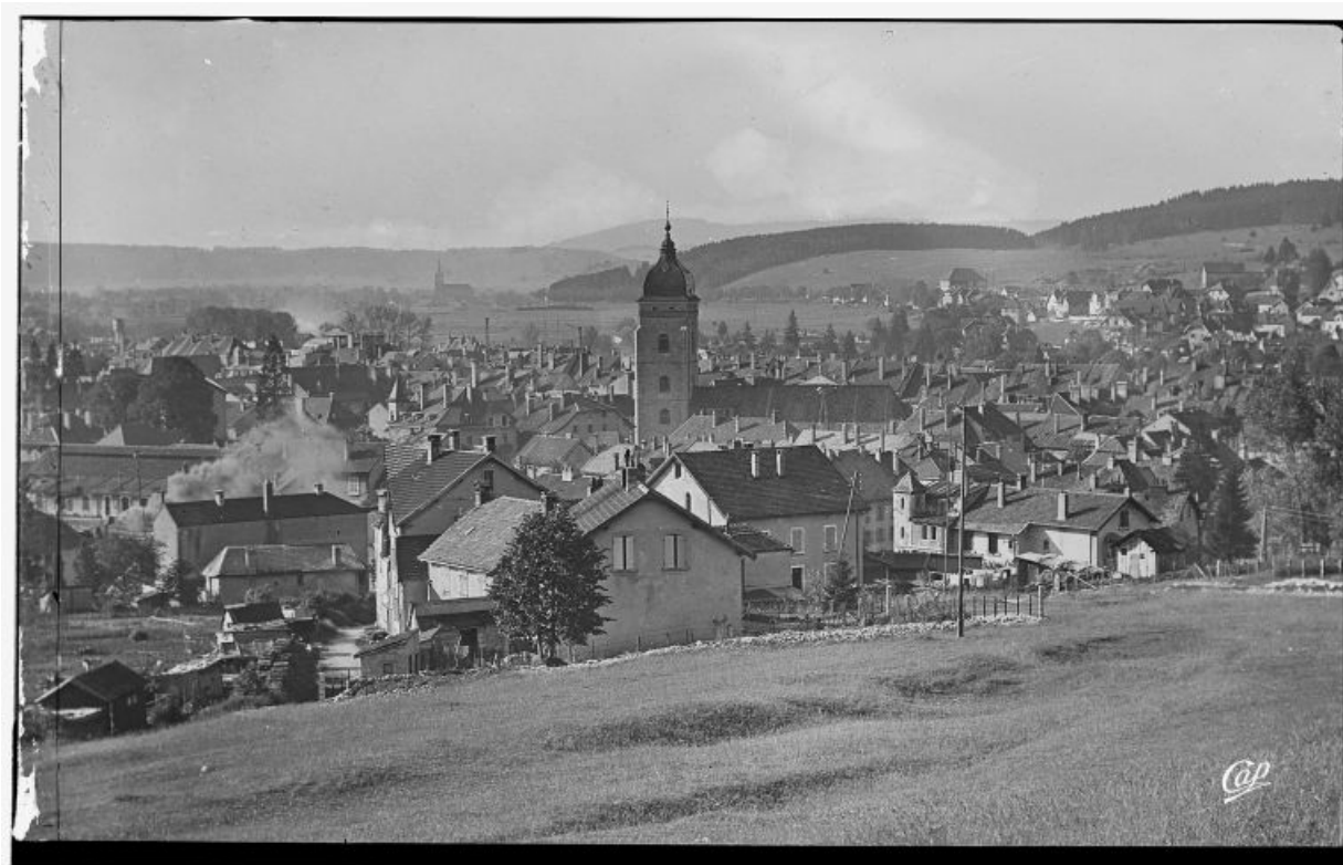
Vue de situation [1re moitié 20e siècle].
