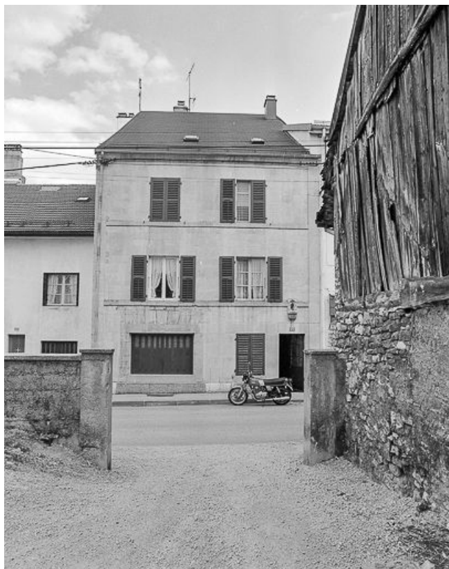
Façade sur rue, vue de face.
