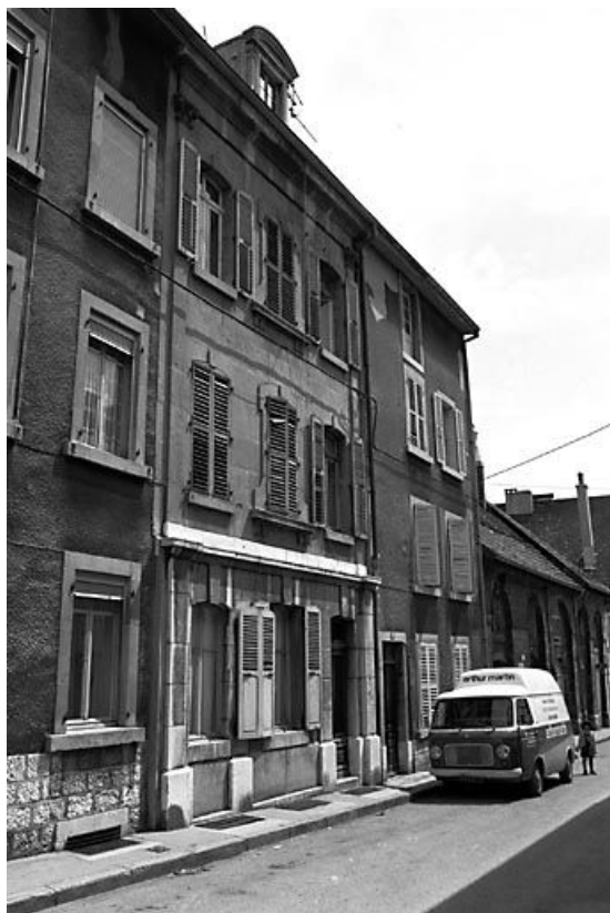
Façade sur rue. 25, Pontarlier
