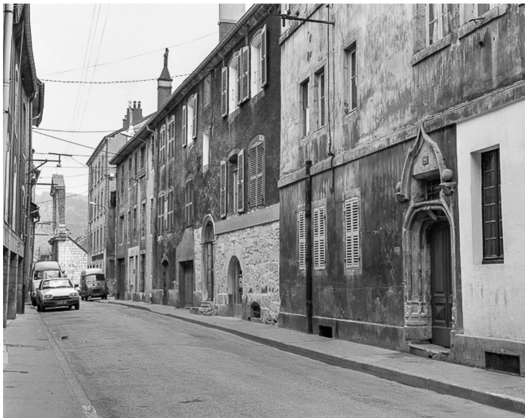
Façades sur rue. 25, Pontarlier
