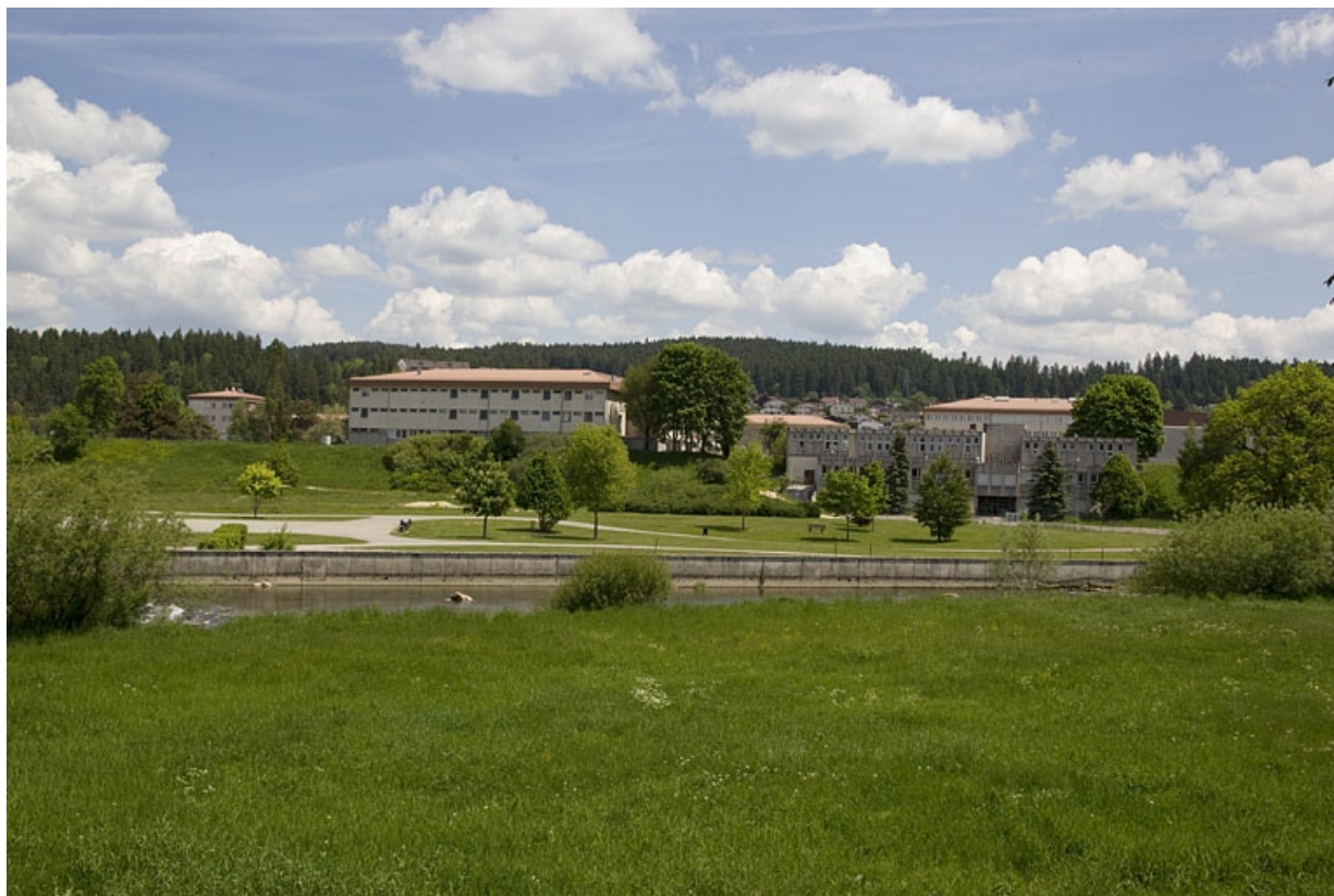
Vue d'ensemble, depuis l'ouest.
