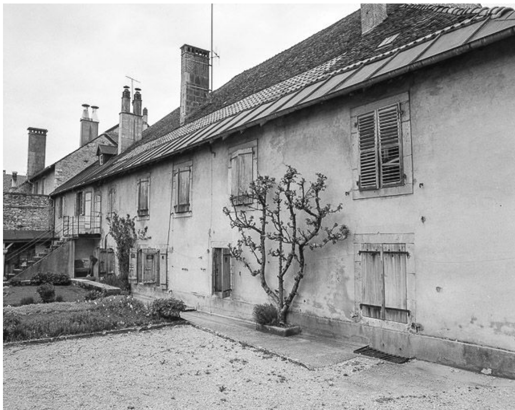
Façade postérieure (habitation).
