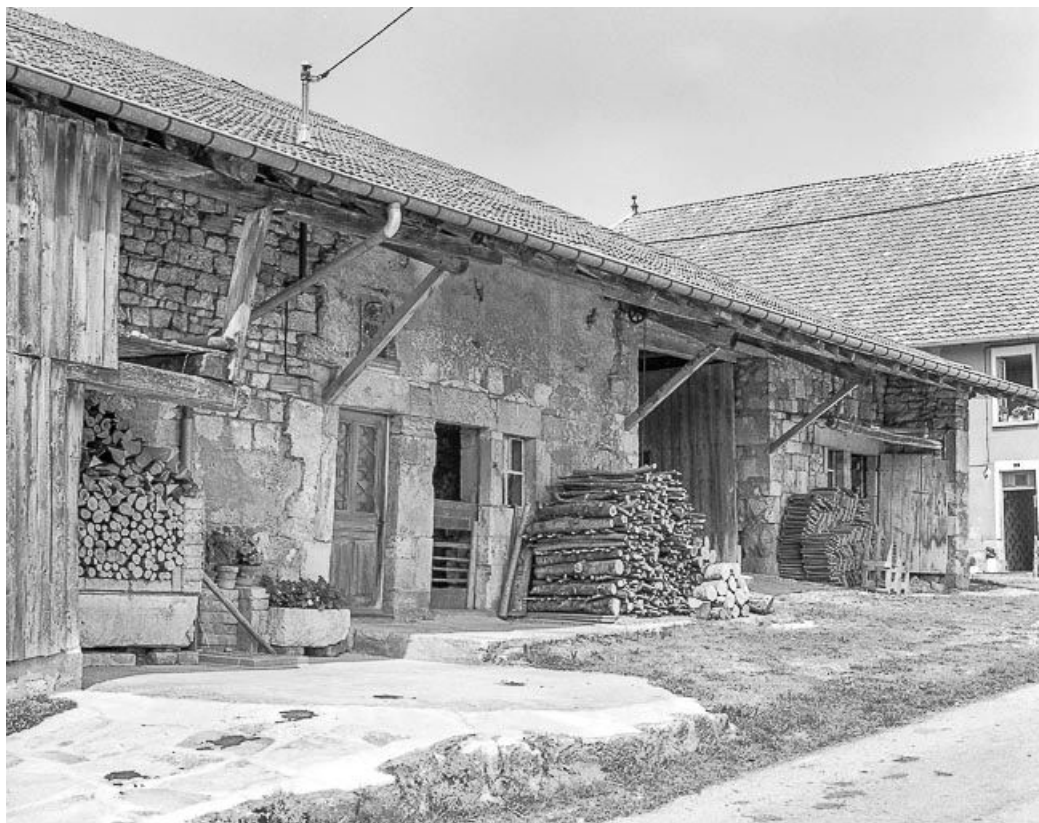
Goutterot sur rue.
