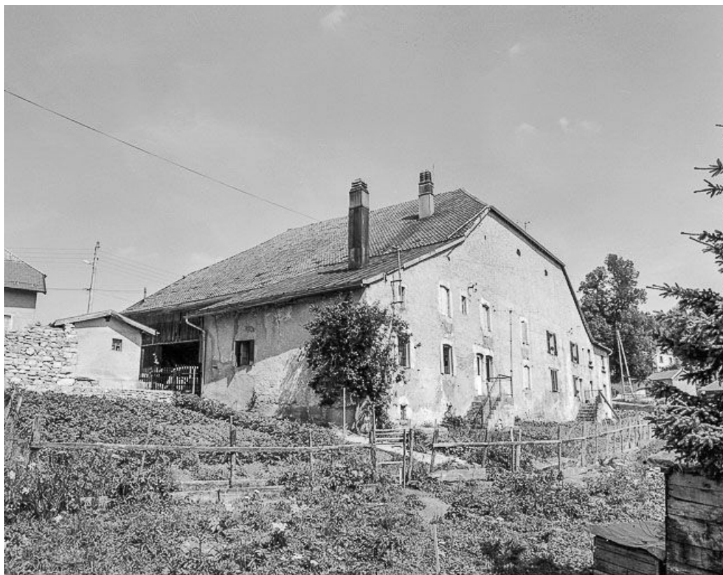
Façades antérieure et latérale gauche.
