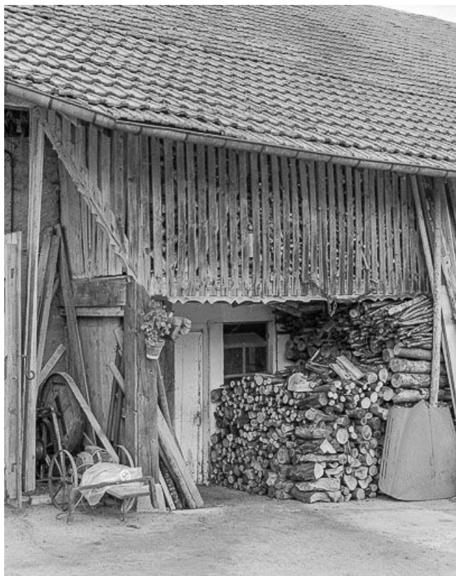
Galerie en bois sous le débord du toit.
