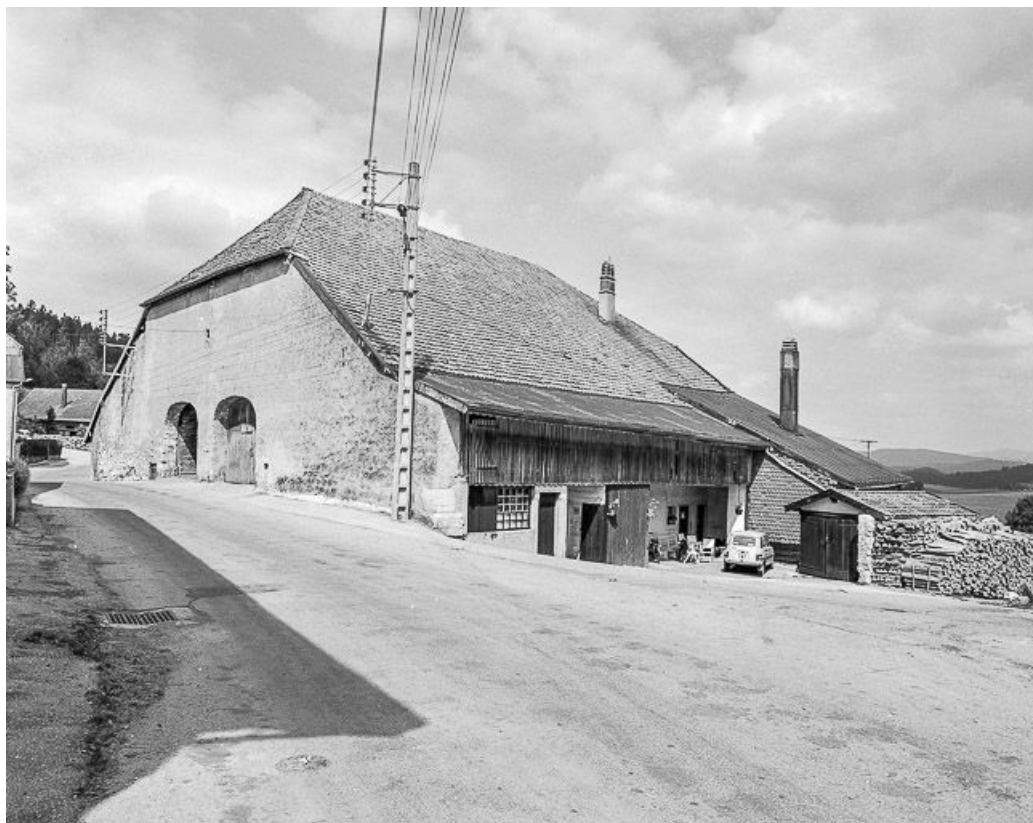
Pignon sur rue et goutterot.
