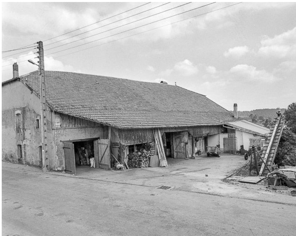
Mur goutterot d'une ferme.
