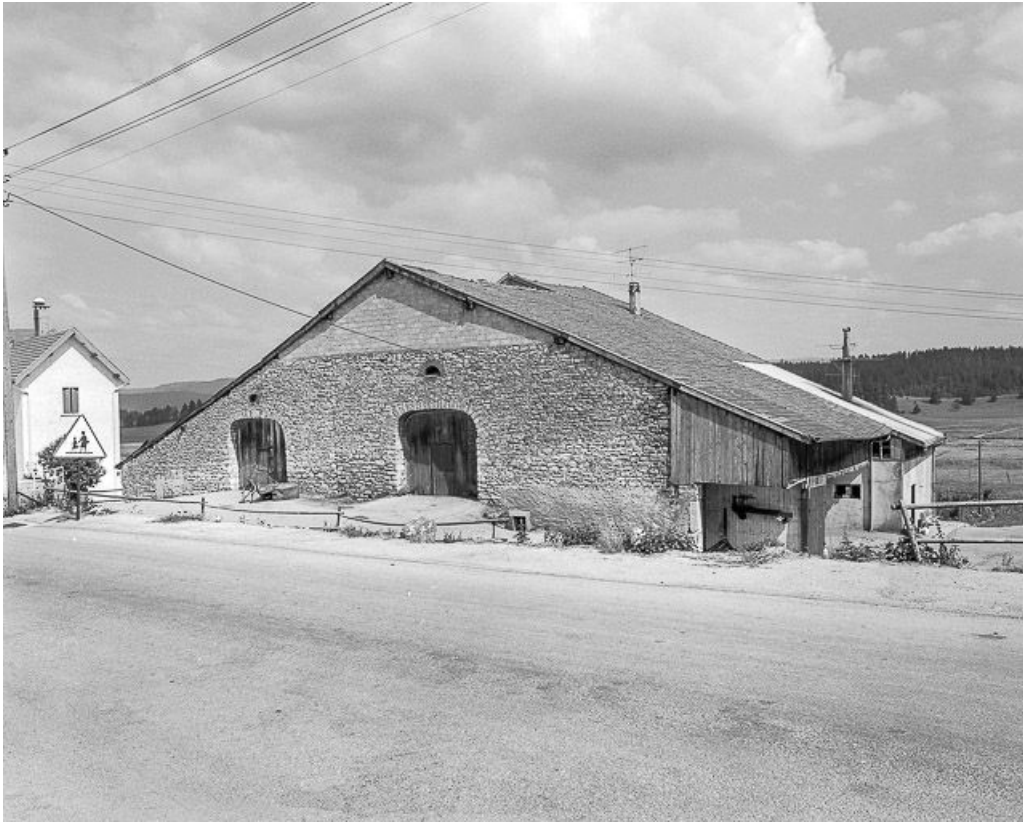
Pignon sur rue et goutterot.
