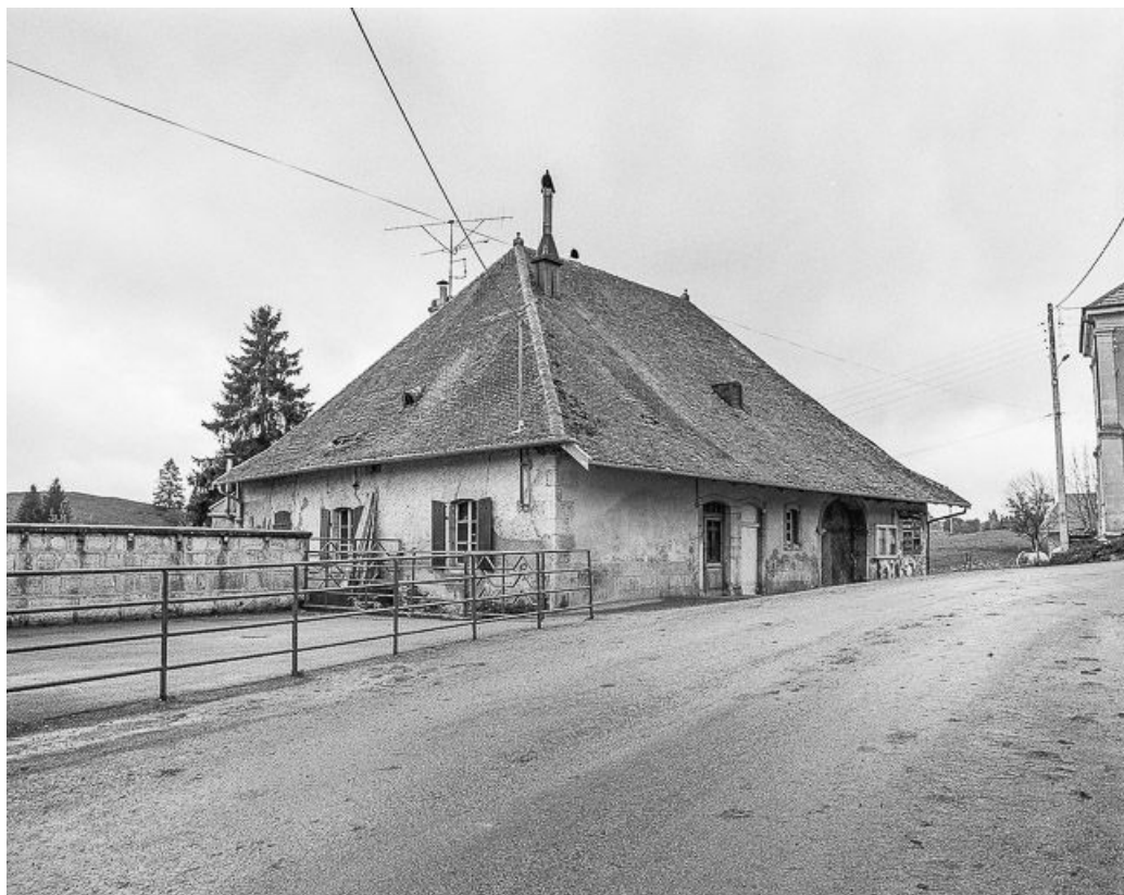
Façade sur rue de trois quarts gauche. 25, Oye-et-Pallet chemin de la Cure
