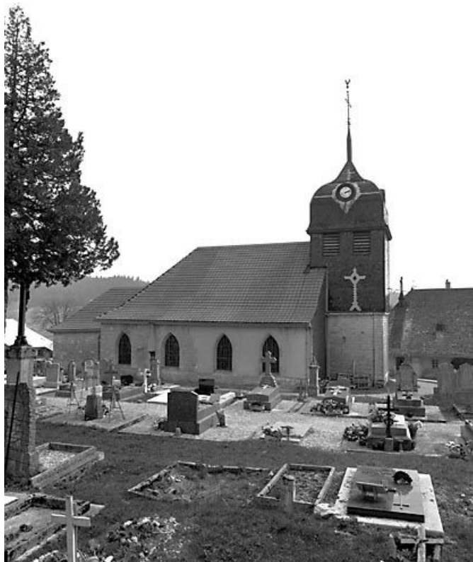
Vue de la façade latérale nord.
