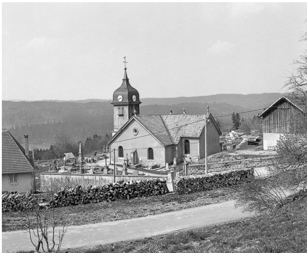
Vue d'ensemble éloignée.
