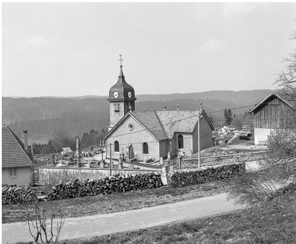
Vue d'ensemble éloignée.
