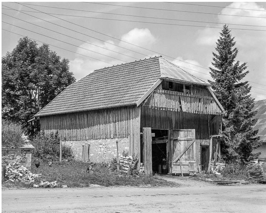
La remise, vue de trois quarts.
