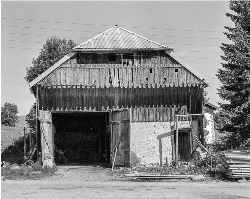
La remise, vue de face.
