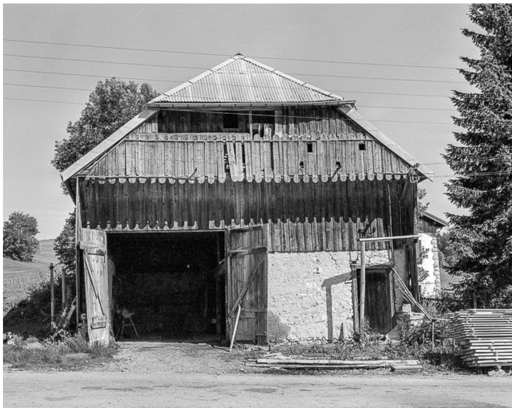
La remise, vue de face.
