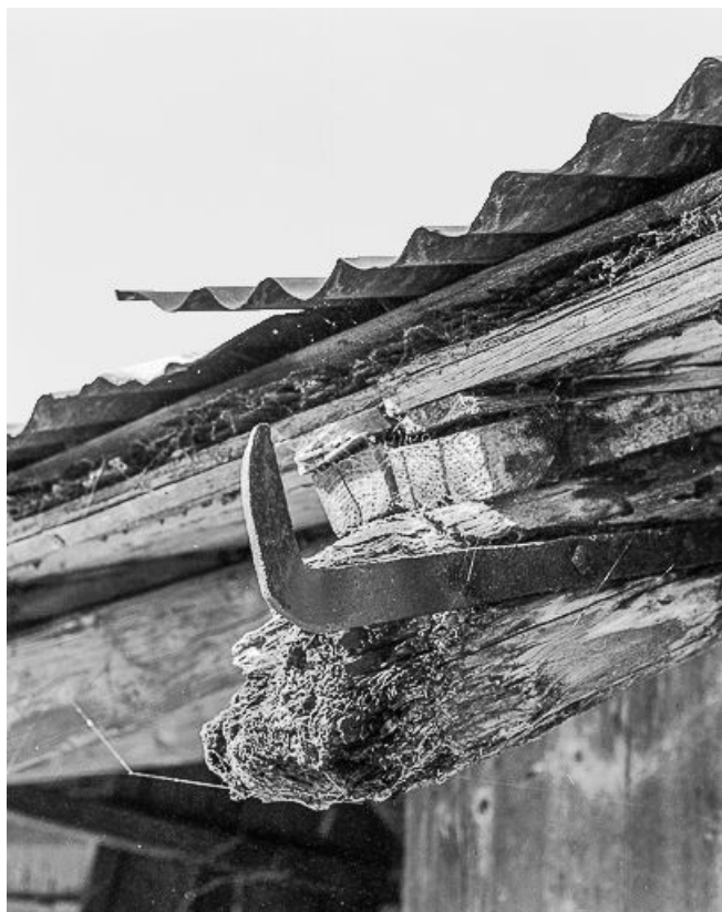
Détail : crochet en fer qui soutenait le chéneau en bois.
