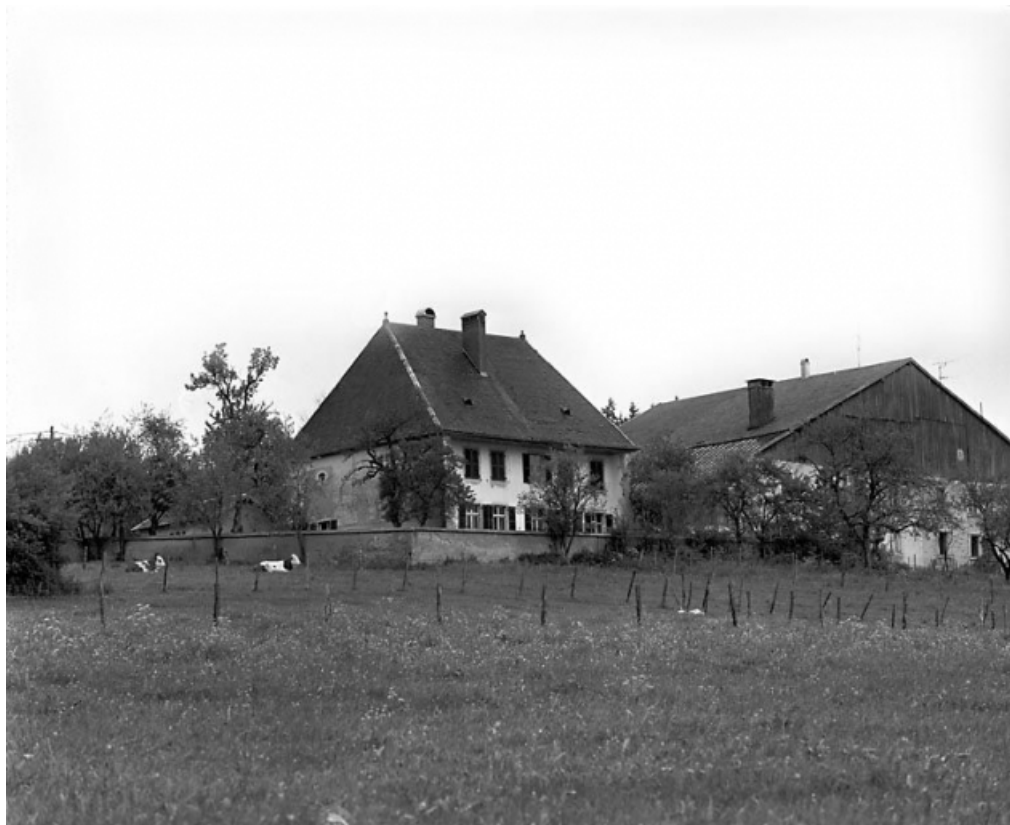
Vue d'ensemble éloignée.
